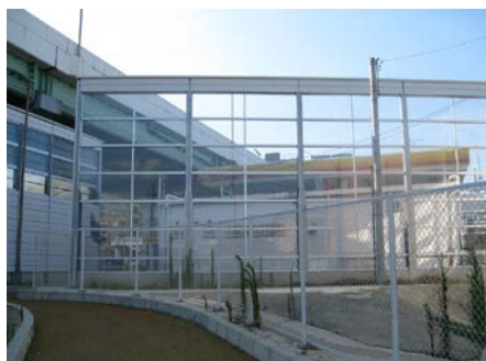
図-5.3 道路に面した商業施設と住居の間に設置した遮音壁
