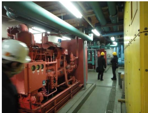
図4-3 機械室の調査（例）
