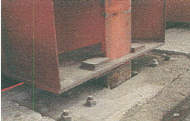
図一A. 12. 349 動きが堅くなった係留装置（1号機）
