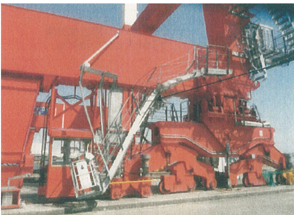
図-A. 12. 370 クレーン乗込み階段の被災状況（4号機）
