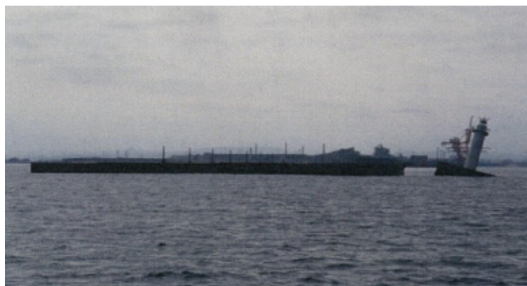
②堤頭函の傾斜（港外より）
