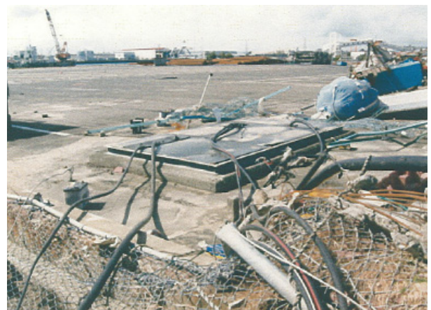
図-A. 12. 373 津波で流出した受電設備跡地
