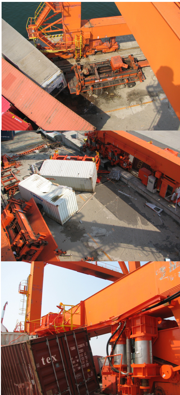
図ーA. 12. 362 ヤードから流出したコンテナの散乱状態 (3号機)
