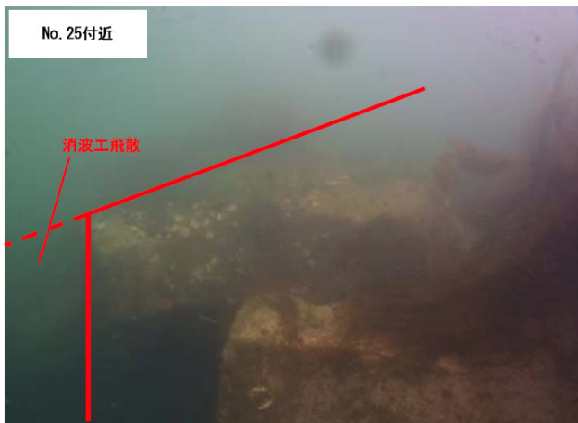
図-A. 4. 17 No. 2 半崎地区_波除堤の被災状況
