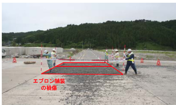
図-A.4.103 No.1 半崎地区_4.0m 物揚場の被災状況
