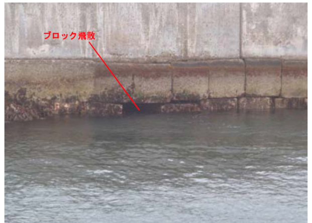
図-A. 4. 33 No. 4 牛島地区_防波堤の被災状況
