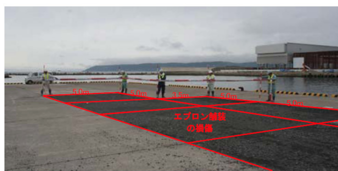
図-A.4.103 No.1 半崎地区_4.0m 物揚場の被災状況
