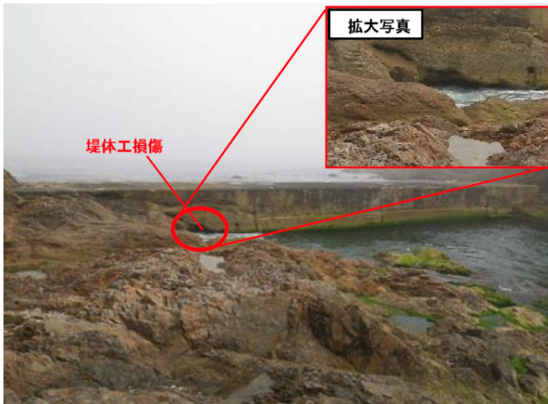
図-A. 4. 33 No. 4 牛島地区_防波堤の被災状況
