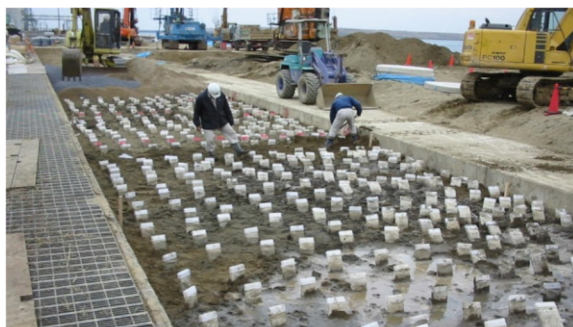
写真-4.8.7 ドレーン打設状況
