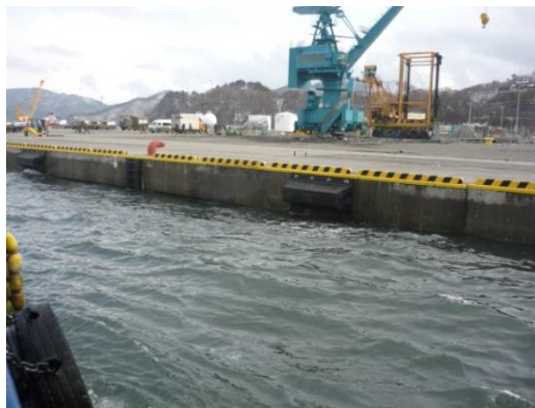
写真-4.6.1 釜石港須賀地区-11m 岸壁（設計震度 0.15）
