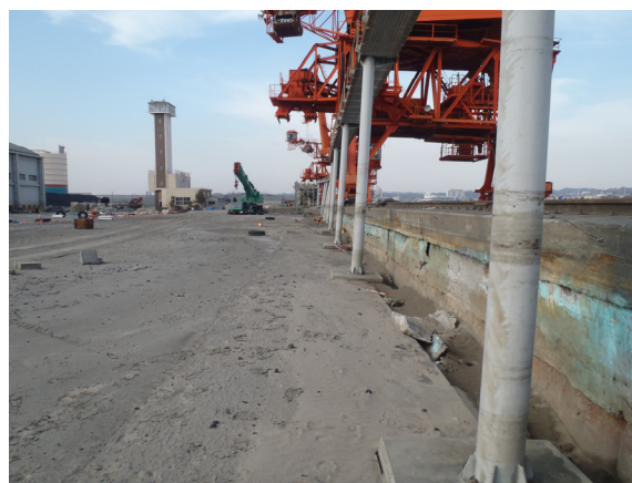
写真-4.8.1(b) 液状化事例 (陸側レール平行方向)
