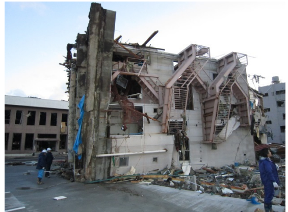
写真-4.7.2 倒壊した4階RC構造物（女川漁港背後地）
