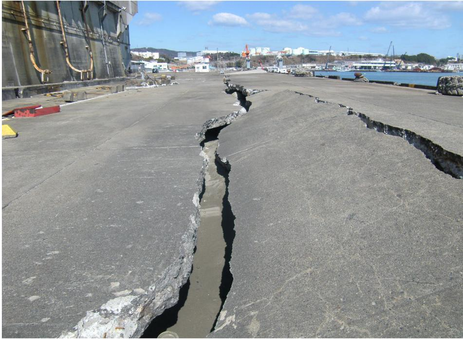
図-3.15.86 No.3 日立港区\_第1ふ頭地区1-C岸壁(-7.5m)の被災状況
