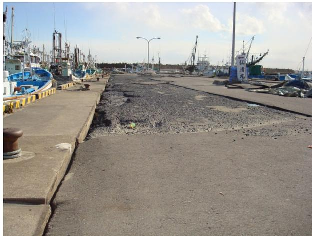
図-3.15.245 No.27 No.28 大洗港区\_第1埠頭 A 岸壁 (-5m) ・ G 物揚場 (-4m) (水産ふ頭地区) の被災状況
