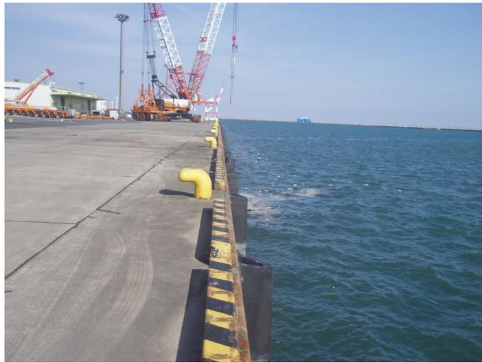
図-3.15.185 No.17 常陸那珂港区\_北埠頭地区 G・H 岸壁 (-5.5m) の被災状況
