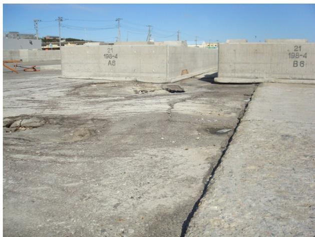
図-3. 15. 258 No.32 大洗港区\_第2埠頭 B岸壁 (-5.0m) 、C岸壁 (-5.0m) (中央地区) の被災状況
