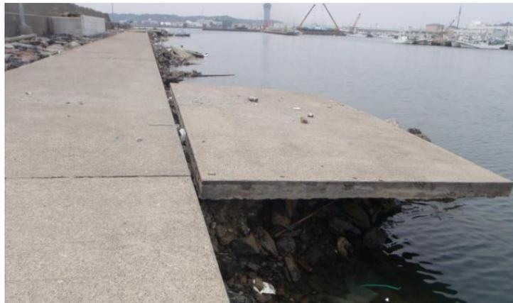
図-3.15.239 No.25 大洗港区\_第1埠頭地区 A 物揚場 (-3m) の被災状況
