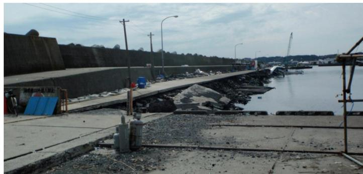
図-3.15.240 No.25 大洗港区\_第1埠頭地区 B 物揚場 (-2m) の被災状況
