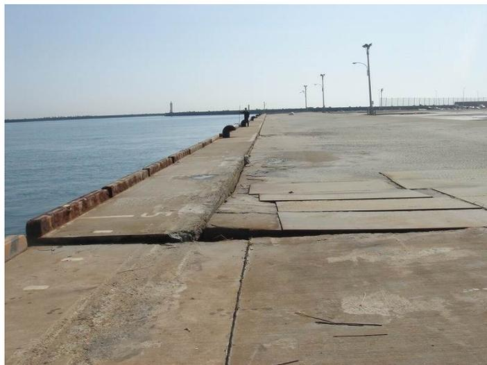
図-3.15.148 No.12 日立港区\_第5ふ頭地区 5-D 岸壁 (-12m) の被災状況
