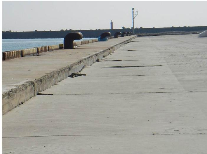
図-3.15.147 No.12 日立港区\_第5ふ頭地区 5-D 岸壁 (-12m) の被災状況
