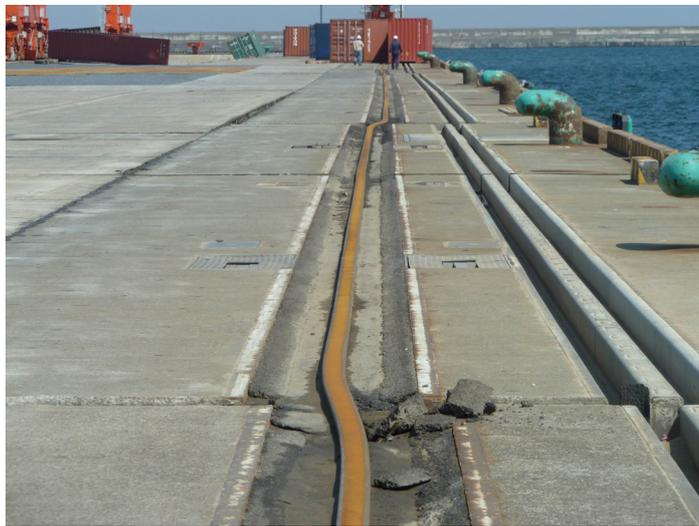
図-3.15.66 No.7 常陸那珂港区\_北ふ頭岸壁(-12m)でのレールの湾曲 (復旧後)
