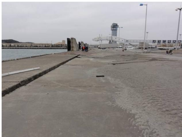
図-3.15.266 No.34 大洗港区\_第3埠頭地区西岸壁 (-8m) の被災状況
