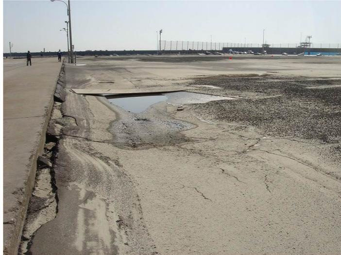
図-3.15.149 No.12 日立港区\_第5ふ頭地区 5-D 岸壁 (-12m) の被災状況
