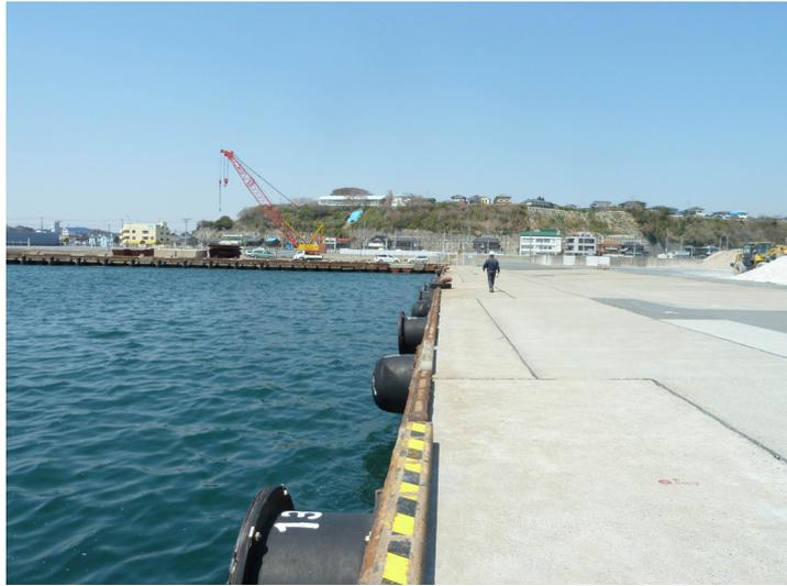
図-3.15.115 No.7 日立港区\_第2ふ頭地区 2-D 岸壁 (-7.5m) の地震後の法線
