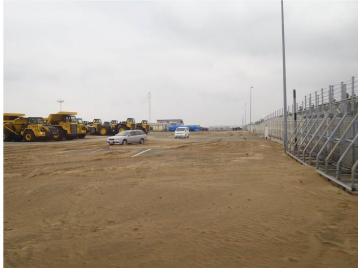
図-3.15.65 No.6 常陸那珂港区\_北ふ頭岸壁(-10m)の背後ヤードでの多量の噴砂
