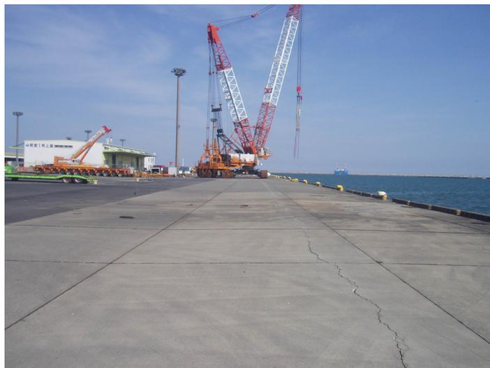
図-3.15.186 No.17 常陸那珂港区\_北埠頭地区 G・H 岸壁 (-5.5m) の被災状況
