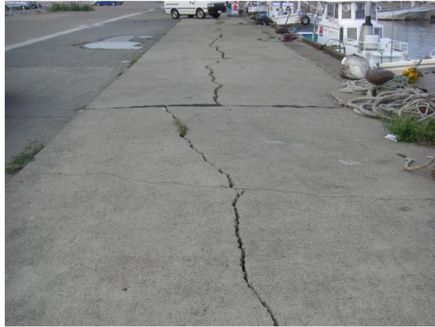
図-3.15.250 No.30 大洗港区\_第2埠頭 A岸壁 (-5.0m) (中央地区) の被災状況
