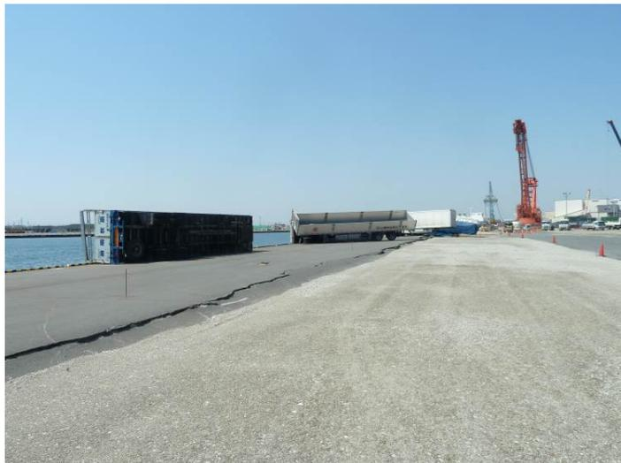
図-3.15.141 No.11 日立港区\_第4ふ頭地区4-E岸壁(-12m)の応急復旧の状況(平成23年4月14日撮影)
