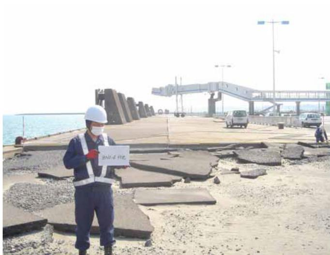
図-3.15.262 No.33 大洗港区\_第3埠頭地区東岸壁 (-8m) の被災状況
