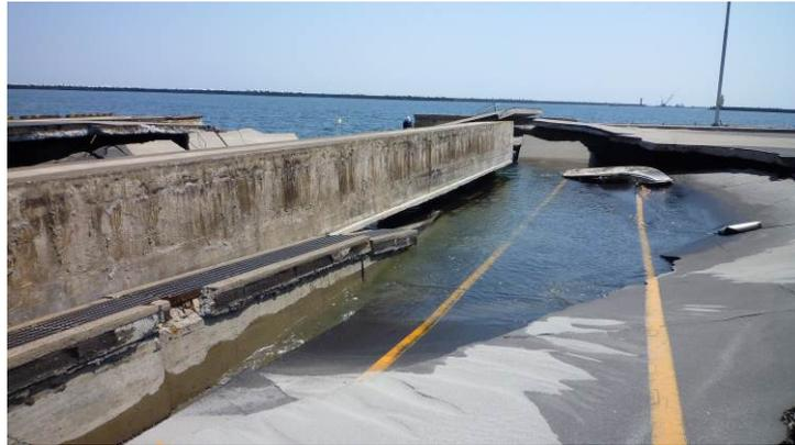
図-3.15.133 No.10 日立港区\_第4ふ頭地区4-D岸壁(-10m)の先端護岸との隅角部でのケーソンの流出
