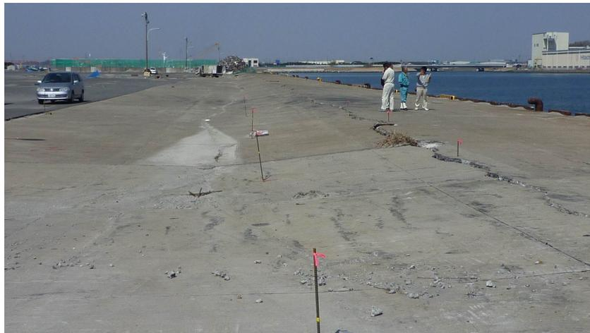
図-3.15.37 No.2 日立港区\_第5ふ頭地区岸壁(-10m)Bの被災状況
