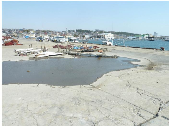
図-3.15.247 No.29 大洗港区\_第1埠頭 C岸壁 (-5.0m) (中央地区) の被災状況
