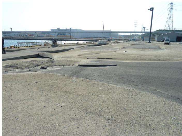
図-3.15.202 No.19 常陸那珂港区\_北埠頭地区 A・B・C 物揚場 (-4m) の被災状況
