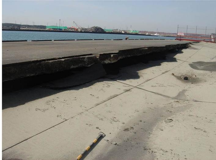
図-3.15.138 No.11 日立港区\_第4ふ頭地区 4-E 岸壁 (-12m) の被災状況
