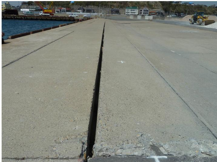
図-3.15.116 No.7 日立港区\_第2ふ頭地区 2-D 岸壁 (-7.5m) の背後地盤の沈下
