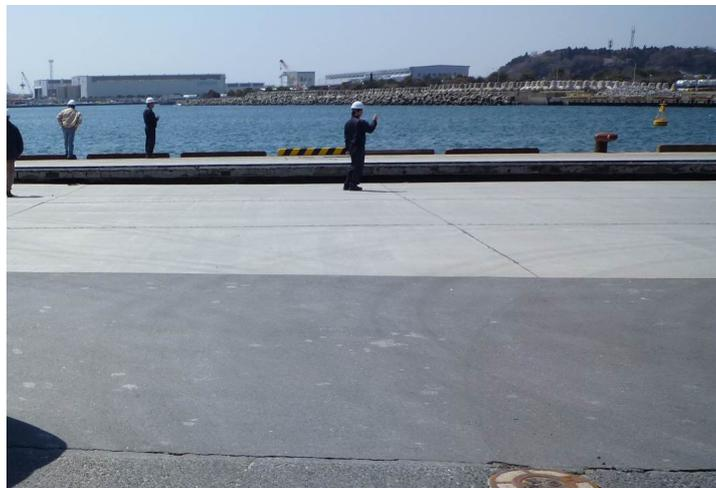
図-3.15.117 No.7 日立港区\_第2ふ頭地区 2-D 岸壁 (-7.5m) のエプロンの段差
