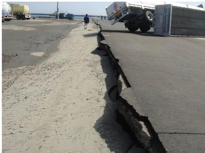
図-3.15.139 No.11 日立港区\_第4ふ頭地区 4-E 岸壁 (-12m) の被災状況
