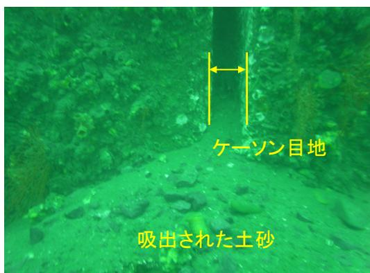
図-3.15.142 No.11 日立港区\_第4ふ頭地区4-E岸壁(-12m)でのケーソン目地の開きによる土砂の流出
