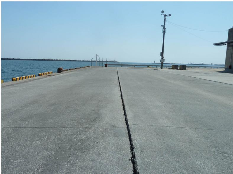
図-3.15.100 No.5 日立港区\_第2埠頭地区 2-B 岸壁 (-9m) のコンクリート舗装目地の開き
