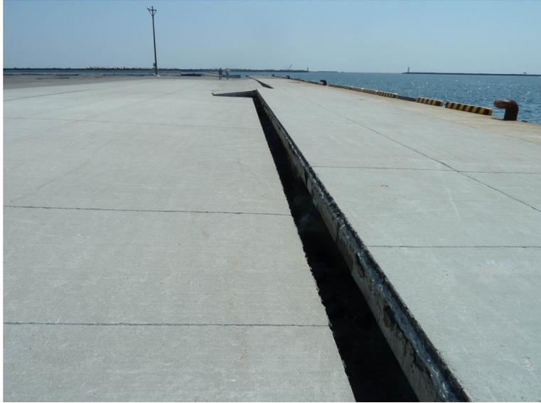
図-3.15.108 No.6 日立港区\_第2ふ頭地区 2-C 岸壁 (-7.5m) のエプロンの段差
