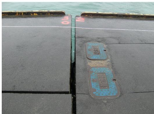
図-3.15.101 No.5 日立港区\_第2埠頭地区 2-B 岸壁 (-9m) におけるケースン目地部の開き
