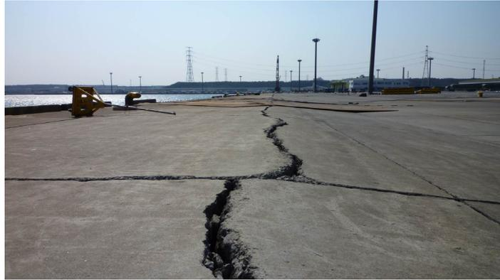
図-3.15.179 No.16 常陸那珂港区\_北埠頭地区 D・E・F 岸壁 (-7.5m) の被災状況
