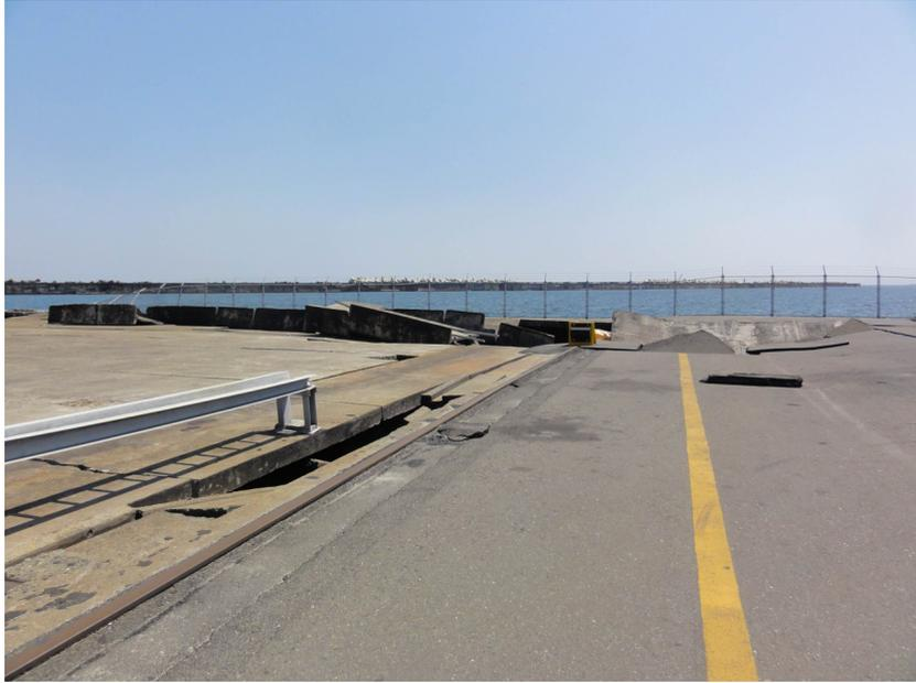
図-3.15.94 No.4 日立港区\_第1ふ頭地区 1-D 岸壁 (-10.0m) の被災状況 (先端護岸付近)
