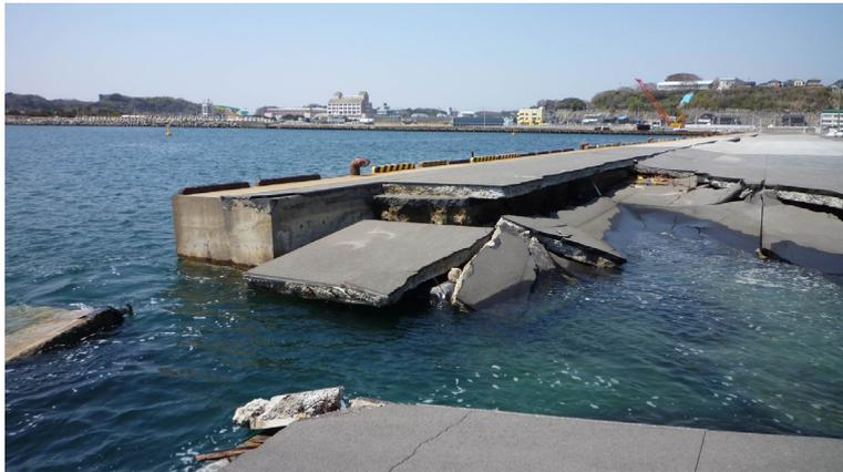
図-3.15.109 No.6 日立港区\_第2ふ頭地区 2-C 岸壁 (-7.5m) の先端護岸との隅角部でのケーソンの流出
