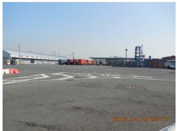
写真-2.5 ゲートオープン前のトラック待機状況2 (BC2ゲート前)
