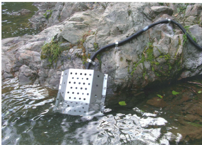
図-1 濁度計保護ケースの事例（1）
