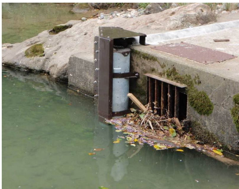
図-2 濁度計保護ケースの事例（2）
