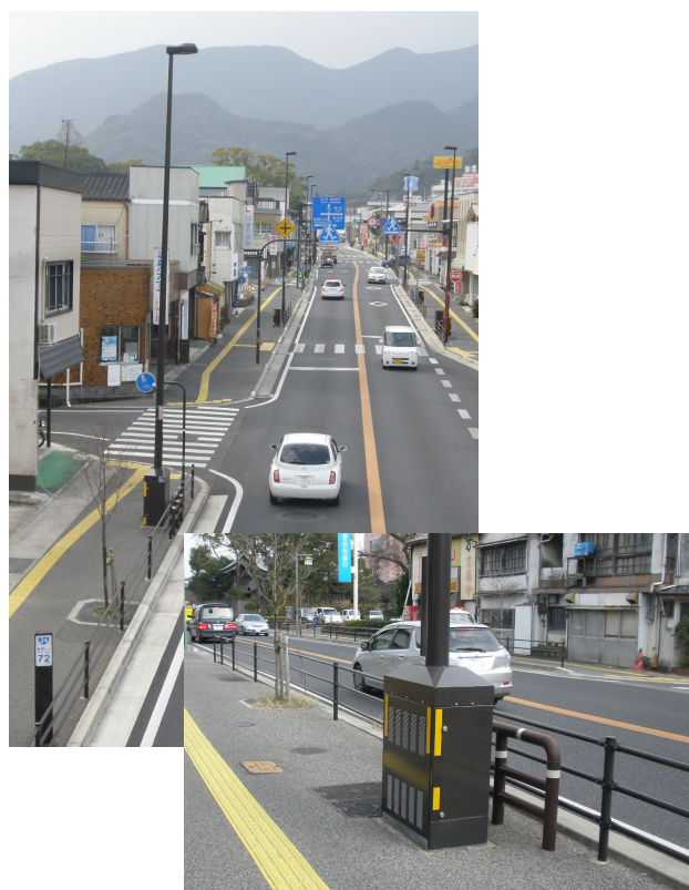
写真 3-6 道路照明と一体化した地上機器の事例
