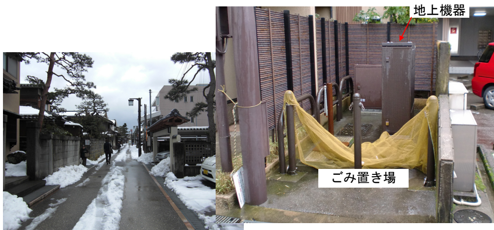
写真 3-3 ごみ置き場に地上機器を設置した事例
