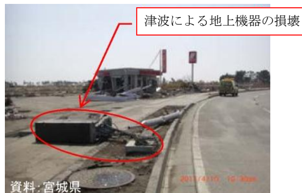
【東日本大震災における電線共同溝の主な被災事例】
