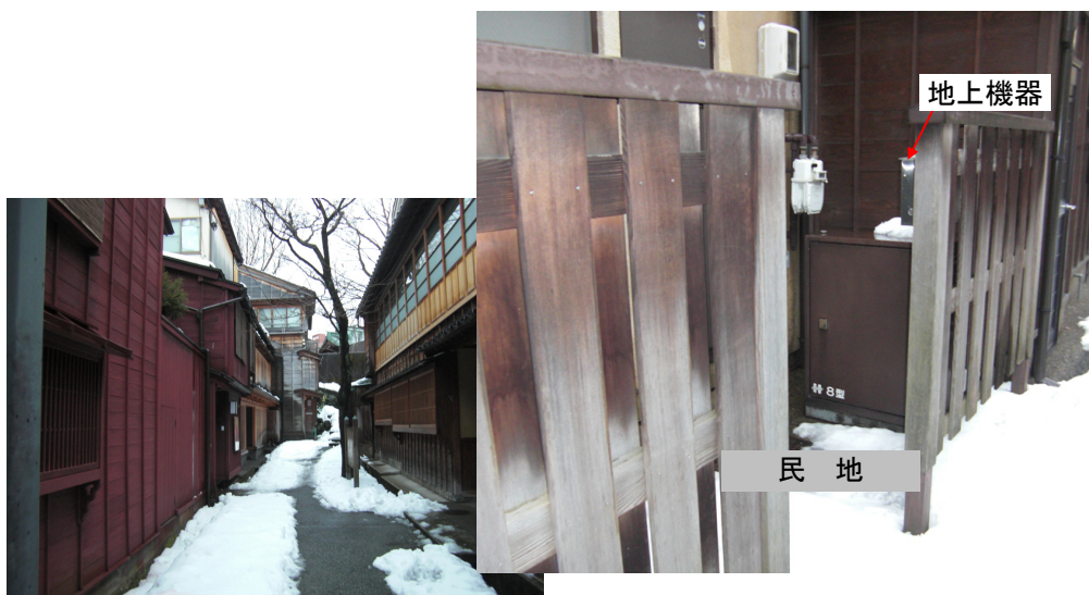
写真 3-4 民地に地上機器を設置した事例
