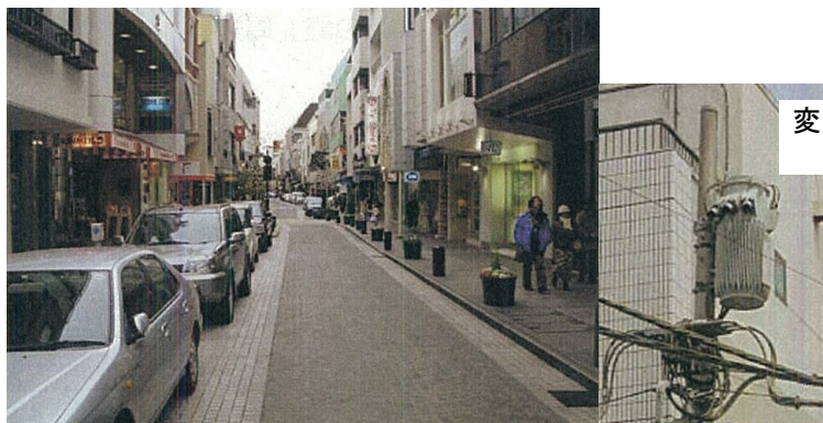
写真 3-2 変圧器を裏通りの電柱に設置した事例
