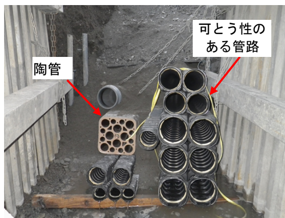
写真 3-1 可とう性のある管路と陶管の活用例
