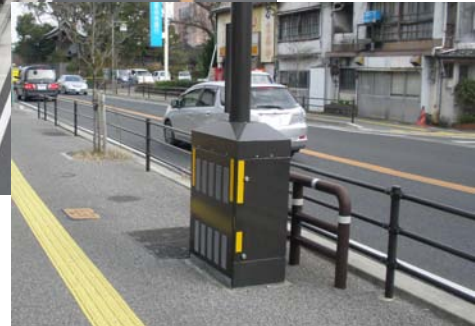
写真 3-6 道路照明と一体化した地上機器の事例
