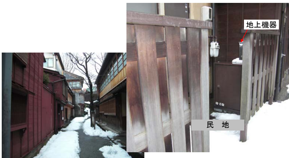
写真 3-4 民地に地上機器を設置した事例
