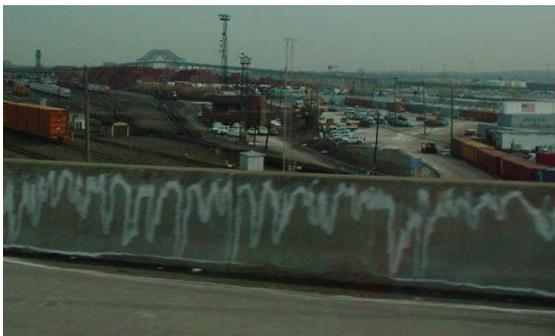
写真 3.5.3 凍結防止剤が付着した壁高欄 (NJTA)
