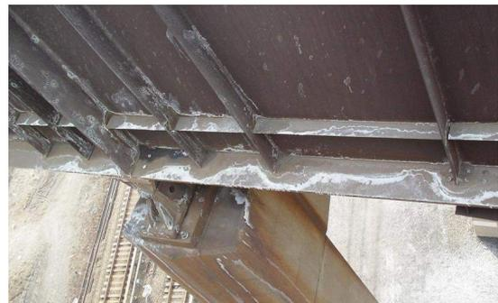
写真 3.5.4 凍結防止剤が付着した橋桁 (NJTA)
