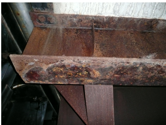
写真 2.2.4 P37 橋脚分離帯下の腐食状況
