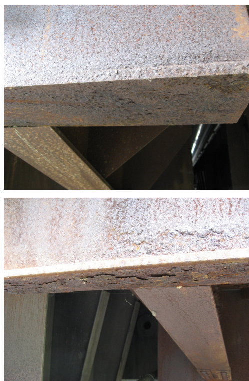
写真 2.2.2 地山側の側縦桁下フランジの外観
