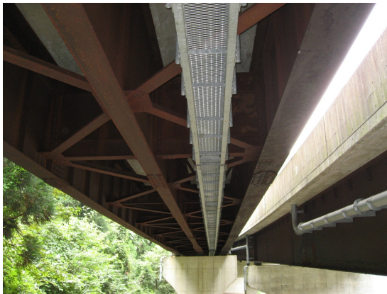
写真 2.2.3 AA2 橋台から見上げた主桁下フランジ
