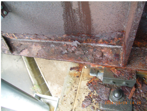
外桁端部 伸縮装置からの漏水による剥離さび
