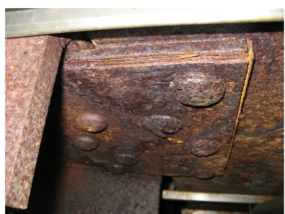
写真 2.2.4 P37 橋脚分離帯下の腐食状況
