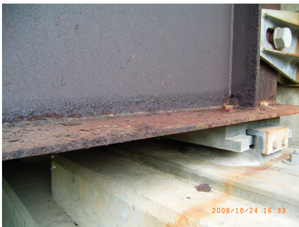
外桁端部 床版からの漏水による剥離さび
