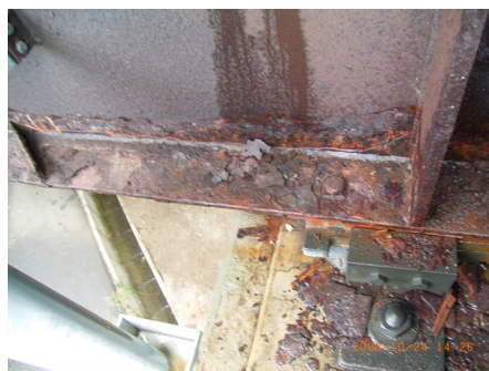
写真 1.2 伸縮装置からの漏水による影響
