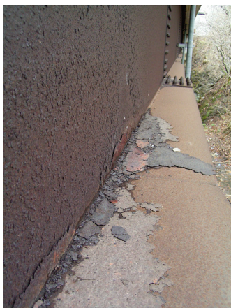
写真 1.1 床版漏水による影響
