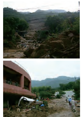
図Ⅱ②-2-4 土石流による被害状況
