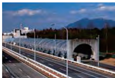
実大トンネル
