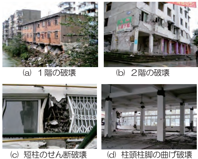
図Ⅱ②-2-3 被害状況
