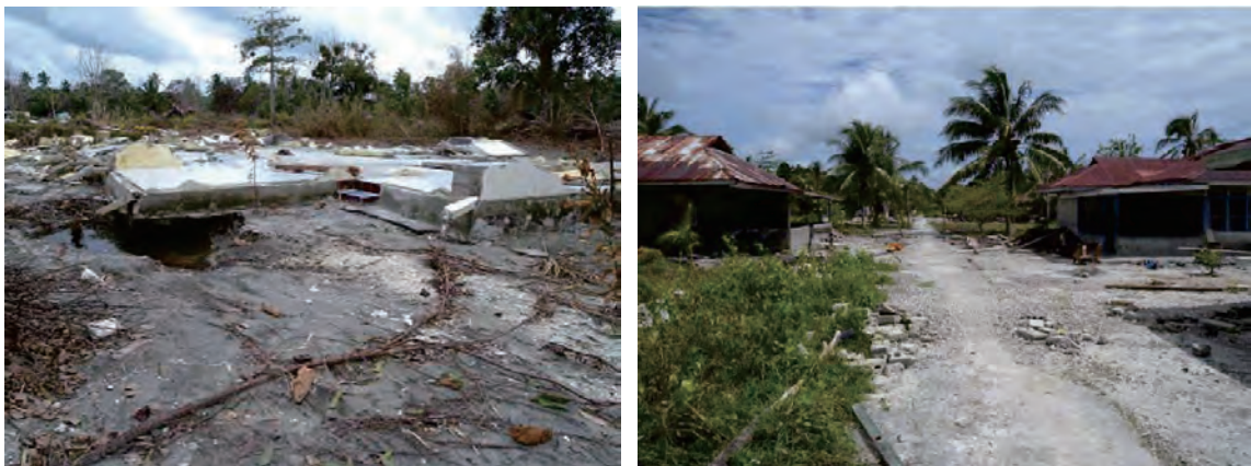
図Ⅱ②-2-5 津波による被害状況
