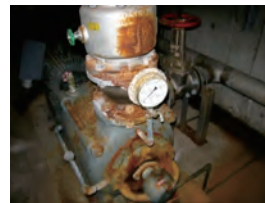
圧搾水ポンプの劣化状況
