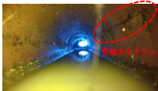
写真9 電動RC制御式カメラの映像
