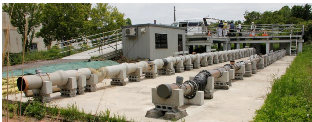
写真2 模擬劣化管きよ
