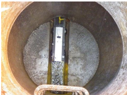
写真8 管きょ内調査の様子
