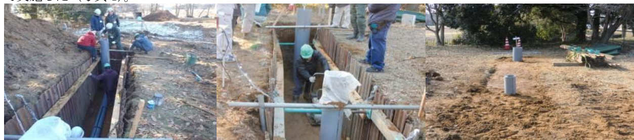
管きょ設置状況
