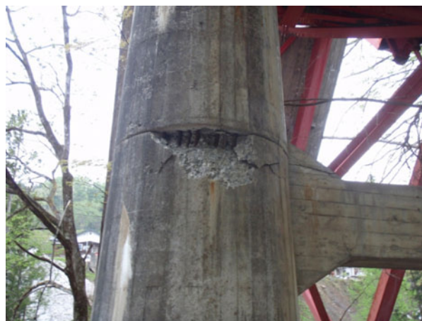
写真-4.1.39 P1 橋脚の損傷状況（写真提供：栄村）
