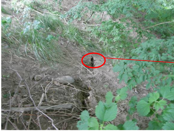
写真-4.3.19 P1 橋脚柱間付近で橋軸方向に伸びる地盤の割れ（その2）
