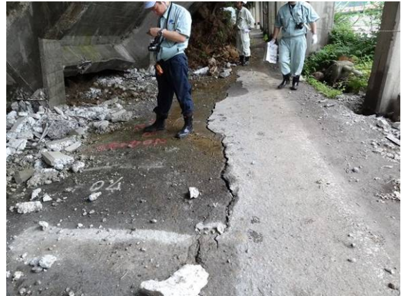
写真-4.6.12 路面のひび割れ
