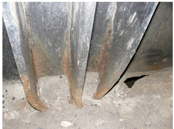
写真-4.2.12 G2 支承上鉛直補剛材の座屈
