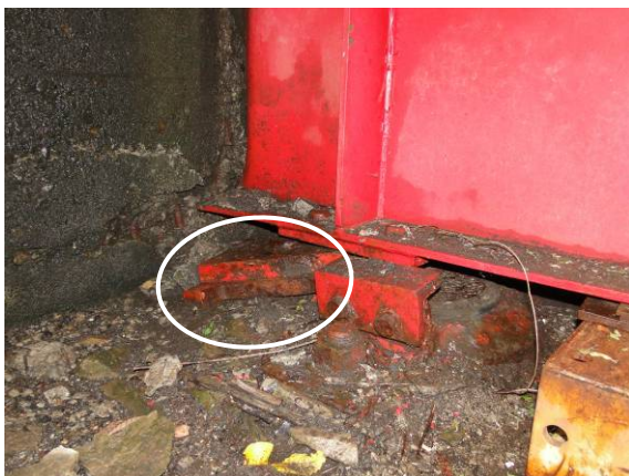
写真-4.2.24 A1 橋台の固定支承の損 傷：上沓が脱落
