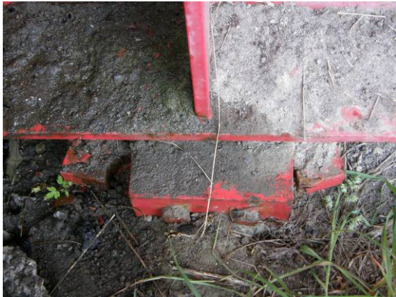
写真-4.4.7 A1 橋台固定支承の両側のストッパーの変形
