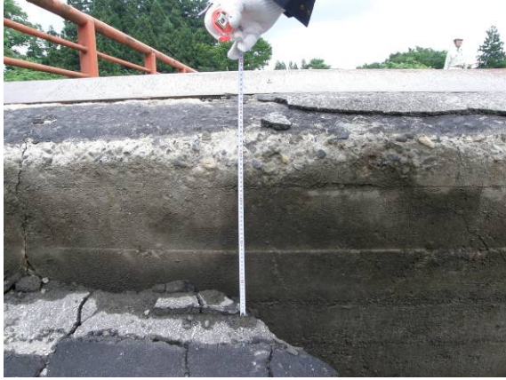
写真-4.1.13 A2 橋台背面の段差 (約50cm)
