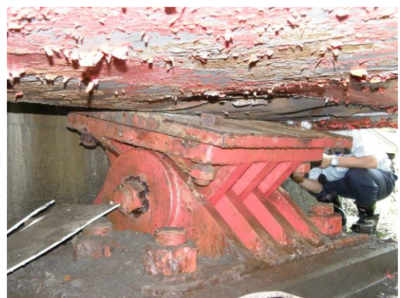
写真-4.2.8 上流側から見た A2 橋台 G2 支承
