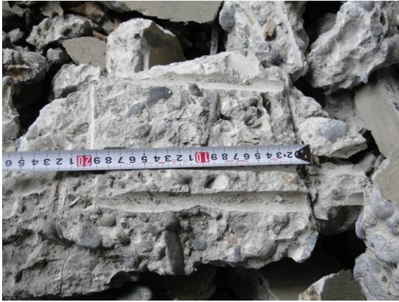
写真-4.6.9 山側柱コンクリートの破片：帯鉄筋間隔は約 200mm
