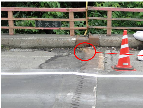
写真-4.2.18 A1 橋台伸縮装置部の損傷（下流側）
