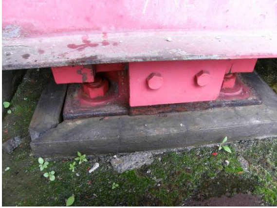
写真-4.4.5 A2 橋台固定支承の両側のストッパーの変形
