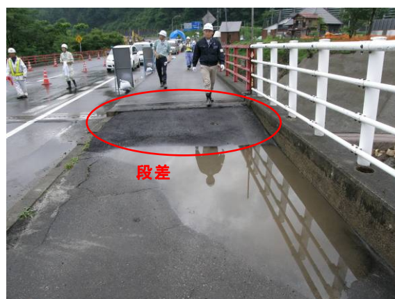
写真-4.4.2 A2 橋台背面の段差
