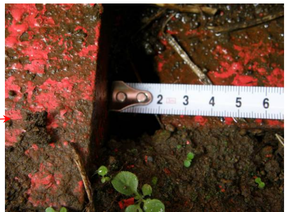
写真-4.3.6 上杓と後側ストッパー間の隙間 (約2cm)
