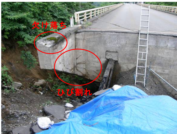
写真-4.5.3 A1橋台ウイングの損傷
