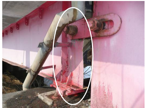
写真-4.2.28 P1 橋脚の箱桁と鋼桁の連結部の損傷状況：鋼桁のウェブの変状 (写真提供：長野県)
