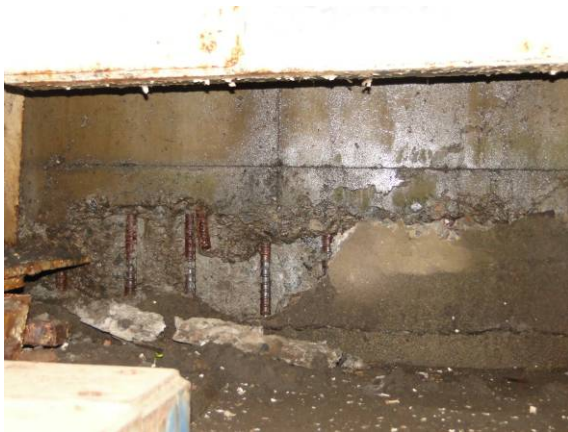
写真-4.2.22 A1 橋台パラペットの損傷： 水平ひび割れ，コンクリー トの欠け落ち
