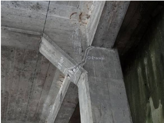
写真-4.6.11 隣接ブロック柱上端部のひび割れ
