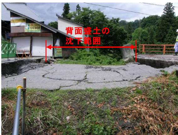
写真-4.1.11 A2 橋台背面盛土の沈下，路面の亀裂
