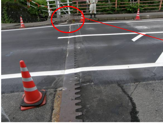
写真-4.2.15 A1 橋台の伸縮装置（下流側から見た上流側）
