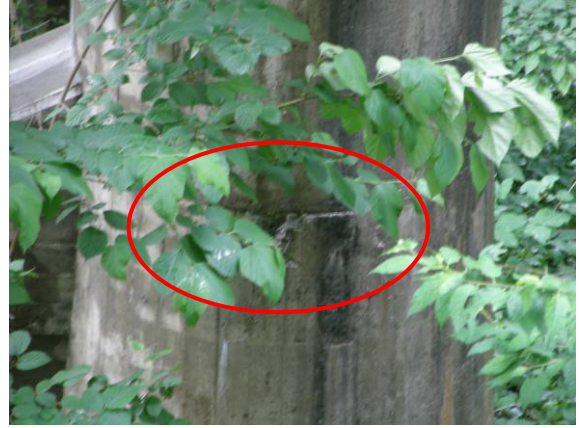
写真-4.1.20 P1 橋脚柱部のコンクリートの損傷（拡大）
