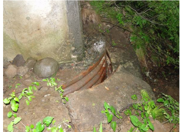
写真-4.3.14 P1 橋脚谷側柱基部の状況： 周辺のコンクリートが割れ 杭頭部が露出
