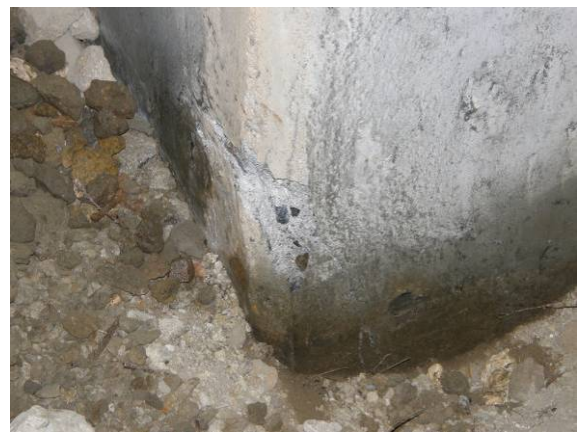
写真-4.3.16 P2 橋脚谷側柱基部の損傷
