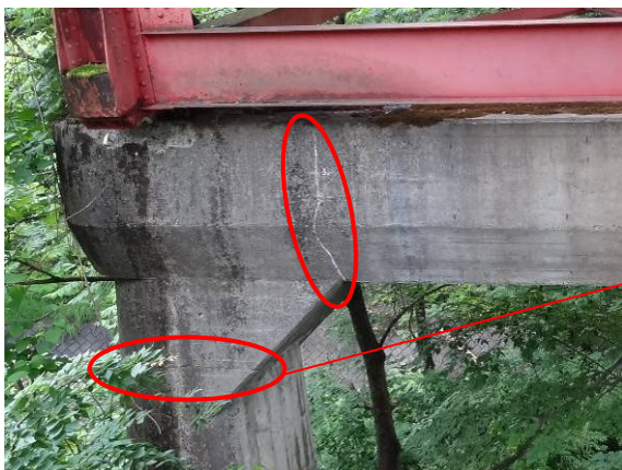
写真-4.1.23 P2 橋脚接合部のひび割れ
