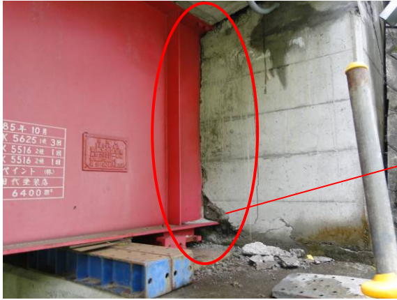
写真-4.2.20 A1 橋台パラペットの損傷 （上流側）：桁端部がパラ ペットに衝突し貫入
