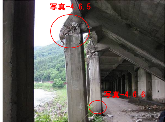
写真-4.6.4 倒壊した箇所箇所の川側柱の損傷
