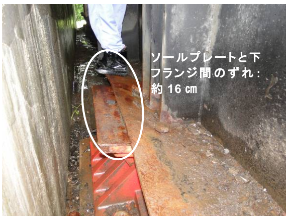
写真-4.2.13 桁背面から見た A2 橋台 G1 支承
