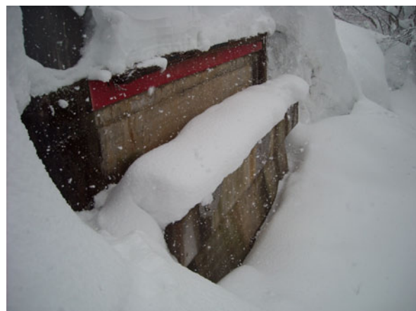
写真-4.1.29 A1橋台の状況 (写真提供：栄村)
