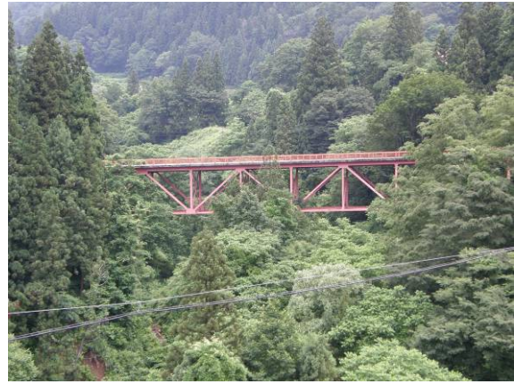
写真-4.1.2 橋梁全景 (トラス桁部)
