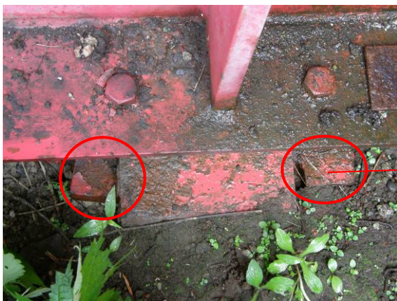
写真-4.3.5 A1橋台固定支承ストッパーの損傷：前後のストッパーとも変形して開いた状態
