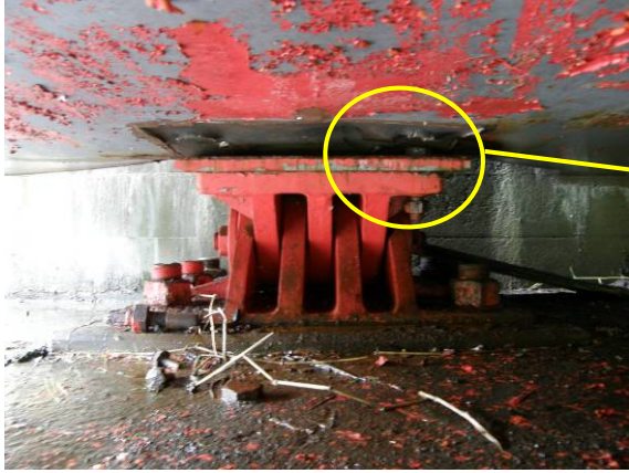
写真-4.2.9 前面から見た A2 橋台 G2 支承
