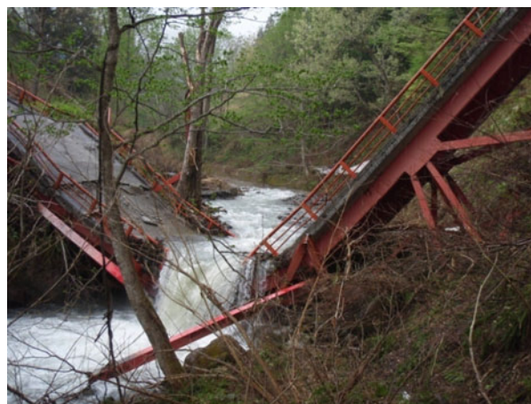
写真-4.1.37 桁が着地した付近の状況（写真提供：栄村）
