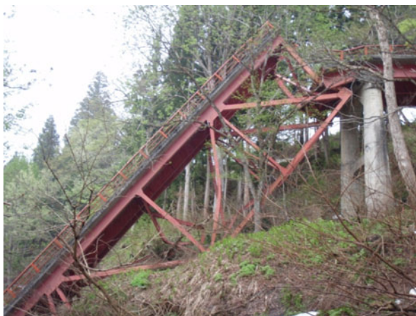
写真-4.1.36 P1 橋脚から脱落したトラス部の状況（写真提供：栄村）
