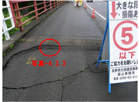
写真-4.3.2 A1橋台背面の段差 (山側)
