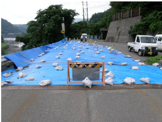
写真-4.5.5 A2橋台背面盛土の沈下
