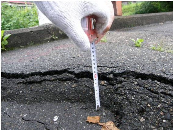
写真-4.3.3 A1橋台背面の段差 (約10cm)
