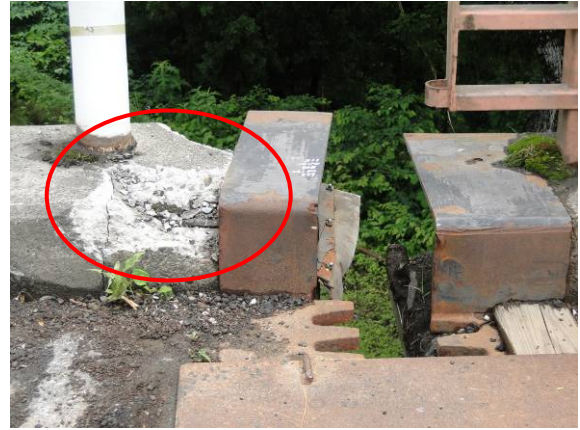
写真-4.2.4 A2 橋台ジョイント部の損傷：伸縮装置の開き（約40cm），地覆端部の破壊
