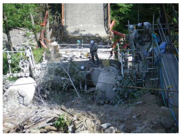
写真-4. 1. 45 P2 橋脚の倒壊状況 (撤去時に A2 橋台側から撮影) (写真提供：栄村)
