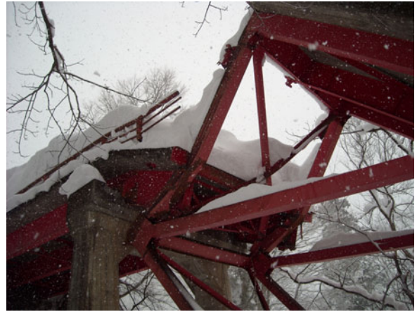
写真-4. 1. 31 P1 橋脚上の状況 (写真提供：栄村)
