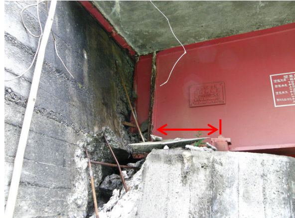
写真-4.1.16 A2 橋台の可動支承の損傷
