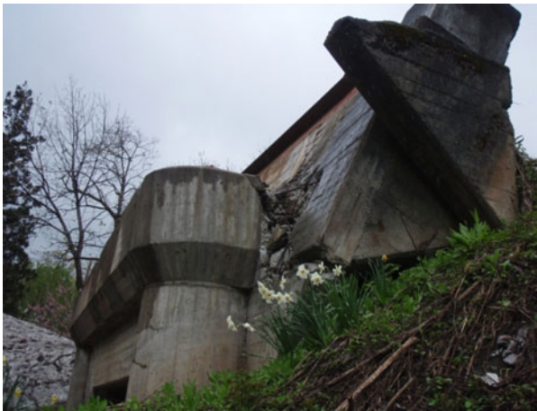
写真-4. 1. 44 A2 橋台の状況 (写真提供：栄村)
