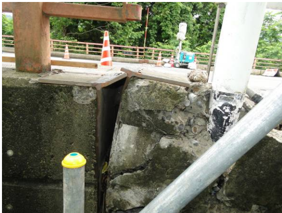
写真-4.2.17 A1 橋台パラペットの損傷（上流側）
