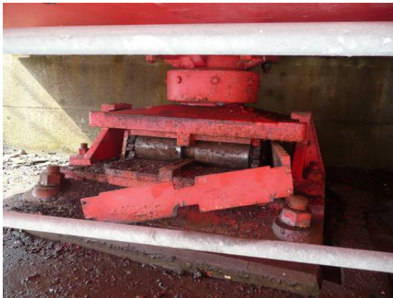
写真-4.2.27 P1 橋脚箱桁 G2 の支承の損傷状況：ローラー支承のカバープレートの脱落 (写真提供：長野県)
