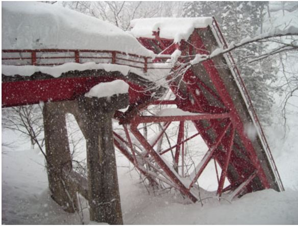
写真-4. 1. 30 P1 橋脚とトラス部の状況 (写真提供：栄村)
