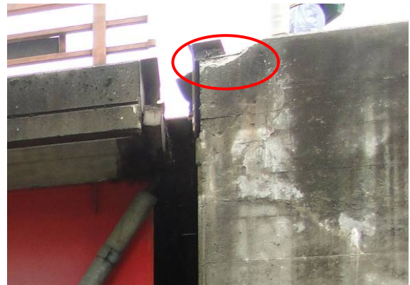
写真-4.2.6 A2 橋台パラペット上部（下流側）（地覆端部）の損傷
