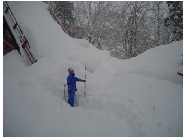
写真-4. 1. 33 桁が着地した付近の状況 (写真提供：栄村)
