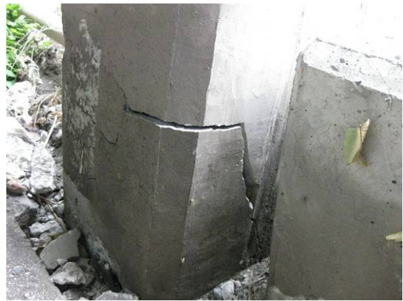
写真-4.6.6 川側柱基部の損傷
