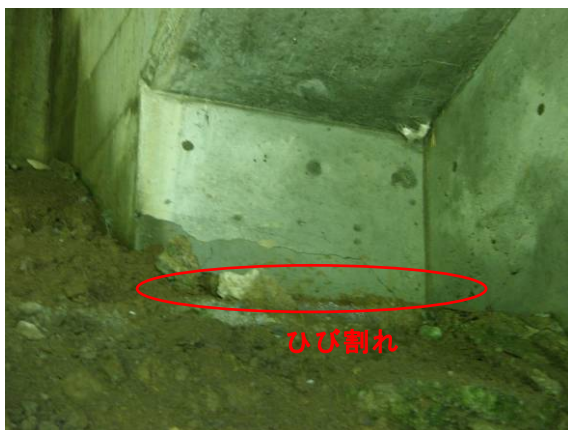
写真-4.3.17 P2 橋脚山側柱基部の損傷
