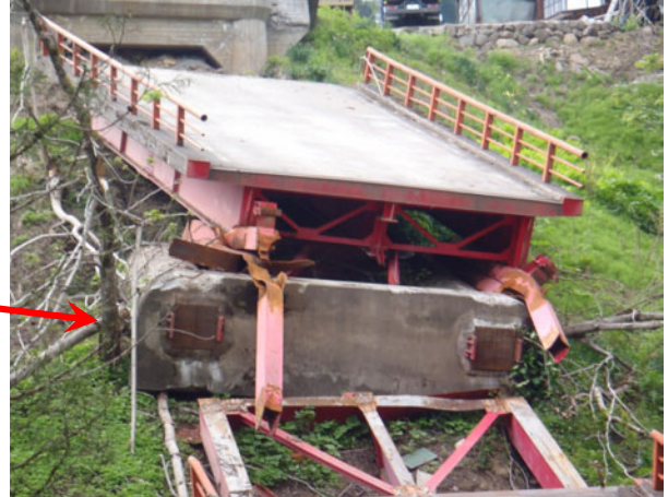
写真-4. 1. 43 P2 橋脚の倒壊状況 (写真提供：栄村)
