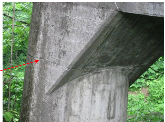
写真-4.1.24 P2 橋脚接合部のひび割れ
