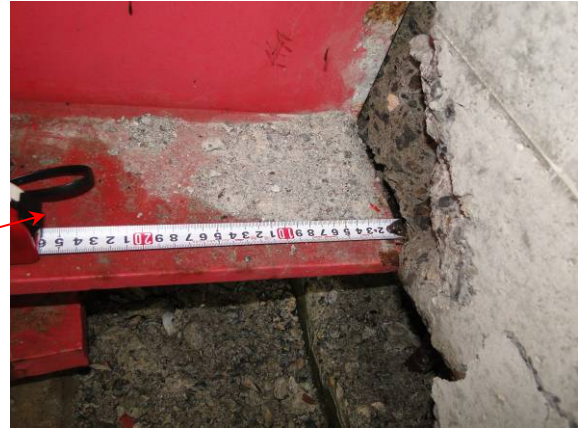
写真-4.2.21 主桁下フランジとパラペッ トの衝突部（貫入深さ約 3cm）
