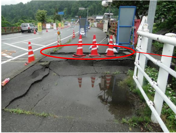
写真-4.3.7 P1 橋脚山側背面盛土の沈下
