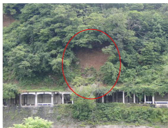
写真-4.6.2 倒壊したスノーシェッド上部の斜面の崩れ
