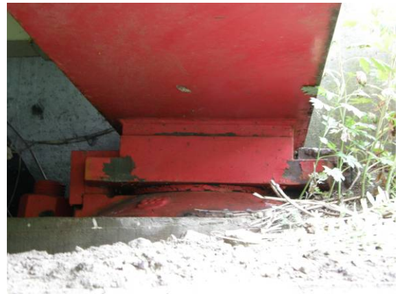
写真-4.3.4 A1橋台固定支承ストッパーの損傷
