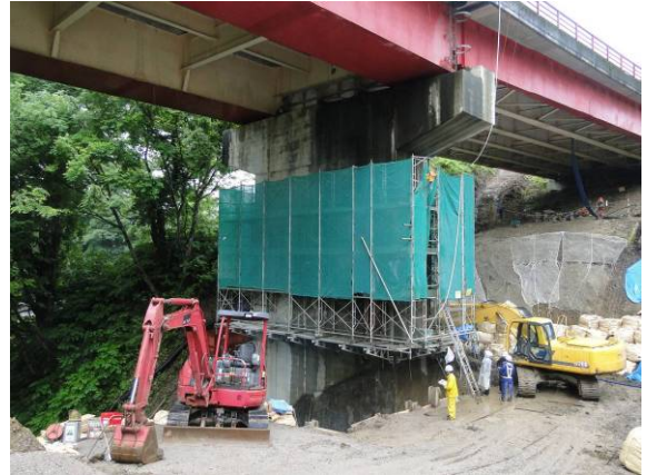
写真-4.4.8 P1 橋脚の状況：損傷箇所の補修工事を実施
