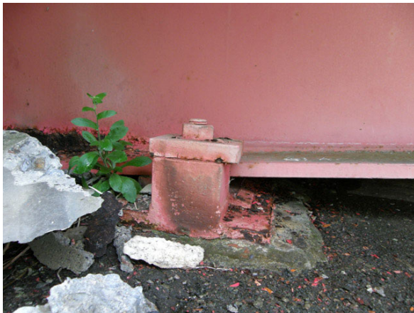
写真-4.1.17 A2 橋台の可動支承の損傷
