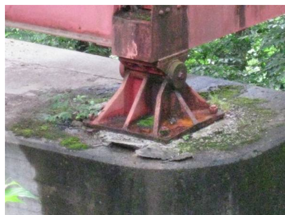
写真-4.1.18 P1 橋脚支承部の損傷 (トラス桁の固定支承)
