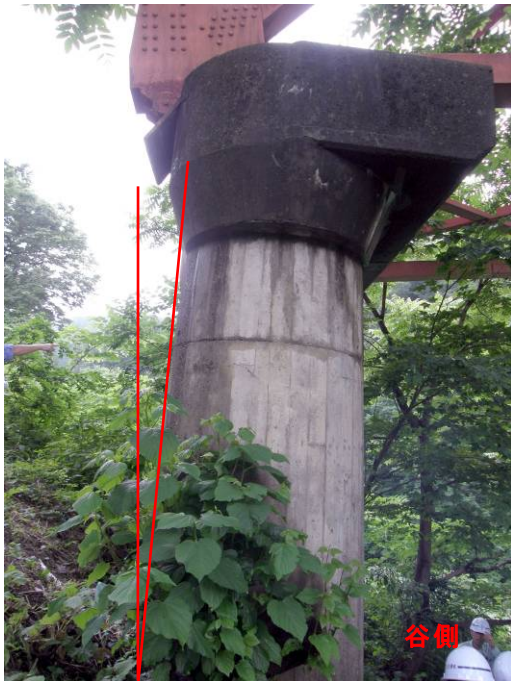
写真-4.1.21 P2 橋脚の傾斜（谷側に5度程度）と支承部の損傷
