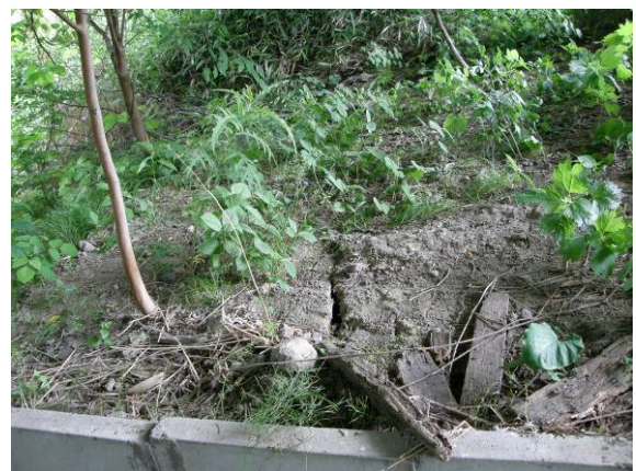
写真-4.3.18 P1 橋脚柱間付近で橋軸方向 に伸びる地盤の割れ (その 1)
