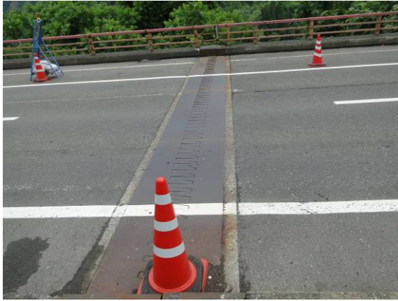
写真-4.2.25 P1 橋脚上の掛け違い部の伸縮装置の状況
