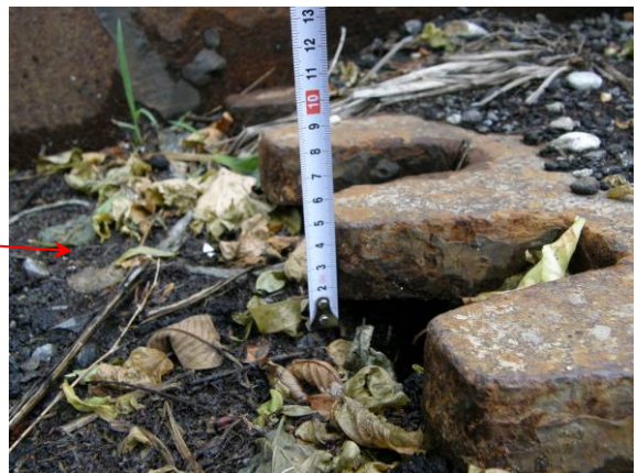
写真-4.2.19 A1 橋台伸縮装置部の段差（約 5cm）
