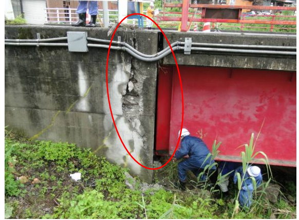
写真-4.4.6 A1 橋台ウイング付け根部の損傷
