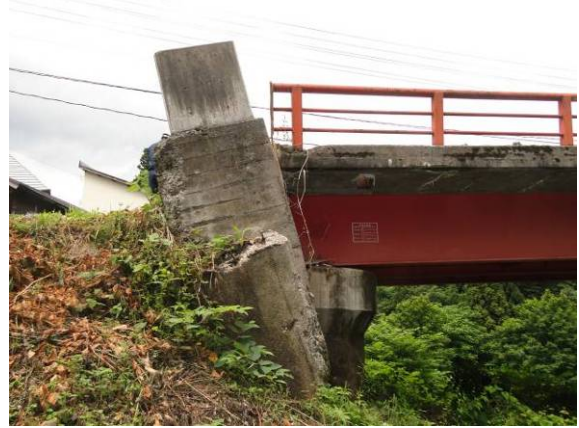
写真-4.1.14 A2 橋台パラペットの傾斜 (13度程度)
