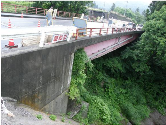
写真-4.3.1 橋梁全景 (A1側より撮影)
