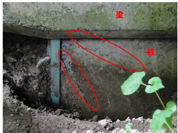
写真-4.3.10 P1 橋脚山側柱上端部の損傷
