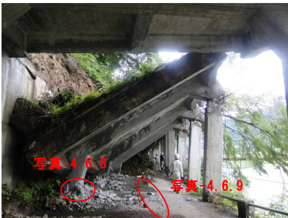
写真-4.6.7 倒壊したシェッドの状況
