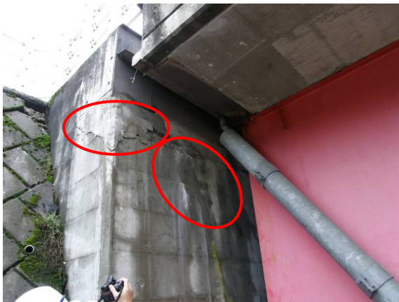
写真-4.2.5 A2 橋台パラペット（上流側）のひび割れ，浮き
