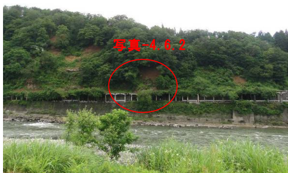
写真-4.6.1 全景（河川右岸側より撮影）
