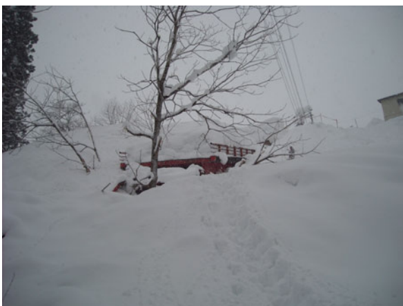
写真-4. 1. 34 P2 橋脚～A2 橋台間の側径間の桁の落橋状況(河道側から) (写真提供：栄村)
