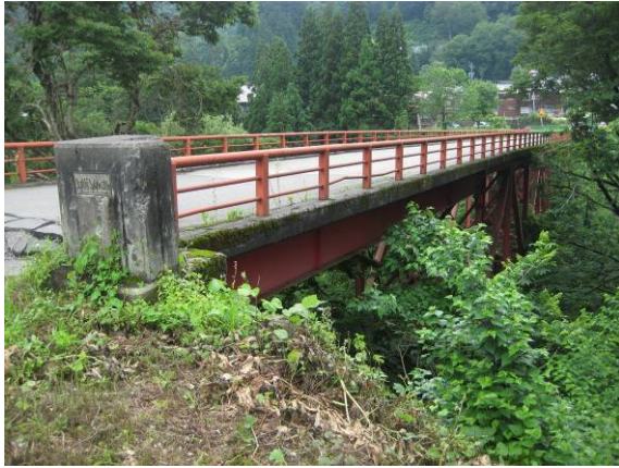
写真-4.1.1 橋梁全景 (A1側より撮影)
