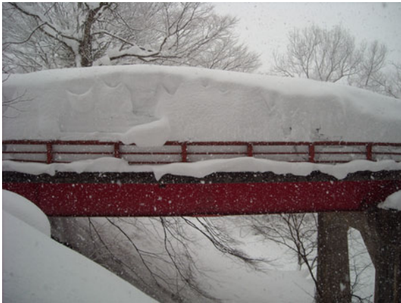
写真-4. 1. 32 A1 橋台～P1 橋脚間の側径間の桁上の積雪の状況 (写真提供：栄村)
