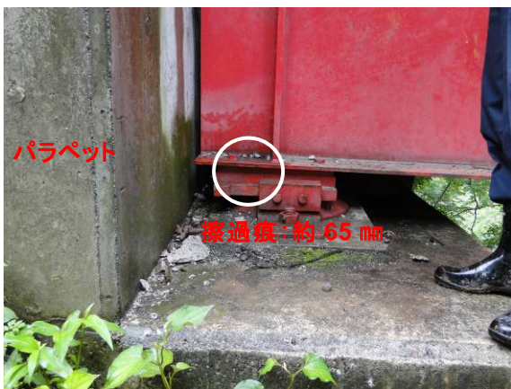
写真-4.3.9 P1 橋脚可動支承の状況
