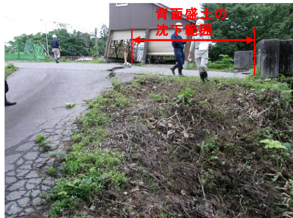
写真-4.1.6 A1 橋台背面盛土の沈下による路面の段差 (上流側から見た下流側)
