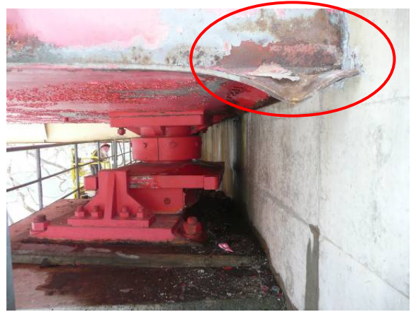
写真-4.2.26 P1 橋脚箱桁端部 (G1) の損傷状況：ウェブと下フランジの座屈 (写真提供：長野県)
