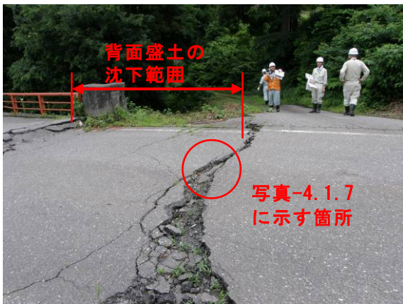
写真-4.1.5 A1 橋台背面盛土の沈下による路面の段差 (下流側から見た上流側)
