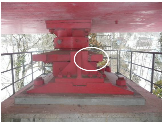
写真-4.2.31 P2 橋脚 G2 支承部の損傷状 況：ストッパーの変状 (写 真提供：長野県)
