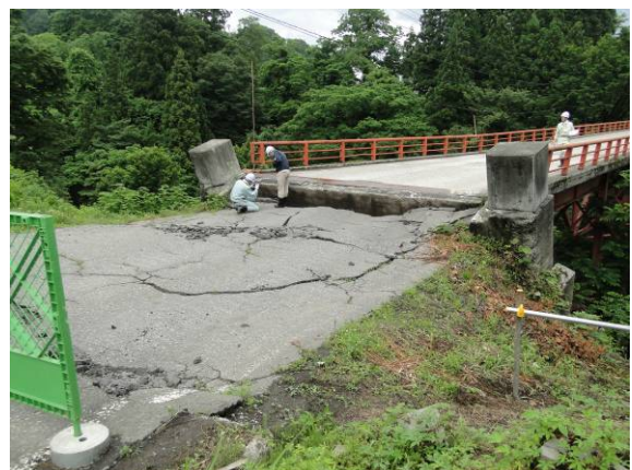
写真-4.1.12 A2 橋台背面盛土の沈下，橋台の傾斜
