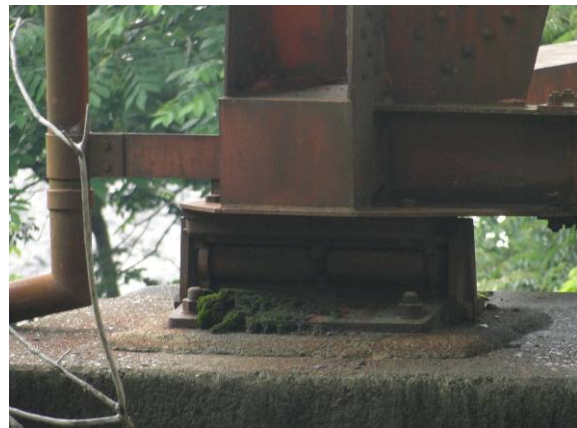
写真-4.5.6 P1橋脚の支承の状況
