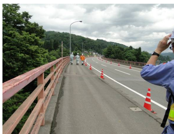
写真-4.2.2 橋面の状況 (A1 側より撮影)
