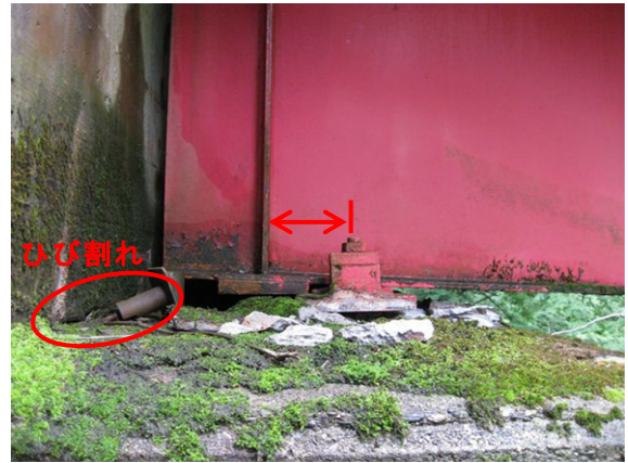
写真-4.1.10 A1 橋台のパラペット基部のひび割れ，可動支承の損傷
