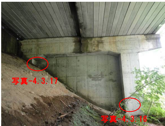
写真-4.3.15 P2 橋脚の状況
