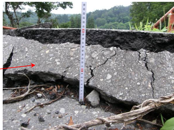
写真-4.1.4 A1 橋台背面盛土の沈下による段差 (約 20cm)
