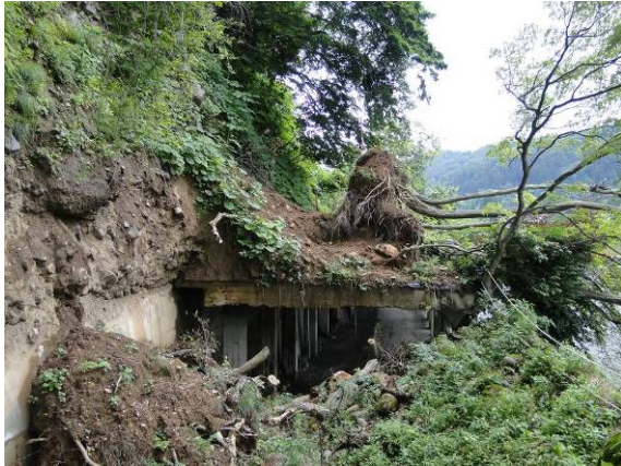
写真-4.6.3 隣接するシェッド上（箕作側）の土砂等の堆積状況
