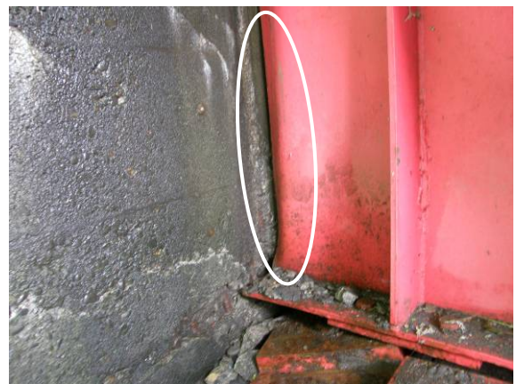
写真-4.2.23 A1 橋台主桁端部（下流側） 衝突部のウェブ座屈
