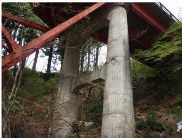
写真-4.1.38 P1 橋脚の状況（写真提供：栄村）
