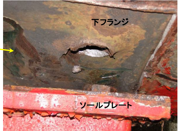
写真-4.2.10 溶接部の破断とずれ
