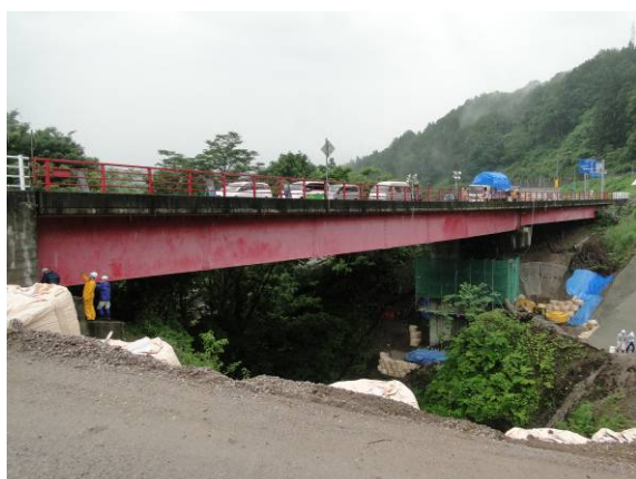
写真-4.4.1 橋梁全景（A2 側より撮影）
