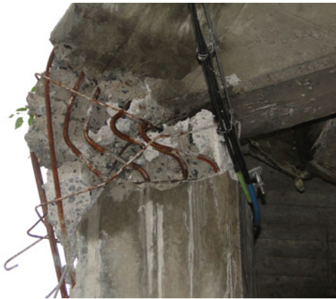
写真-4.6.5 川側柱上部の破壊状況
