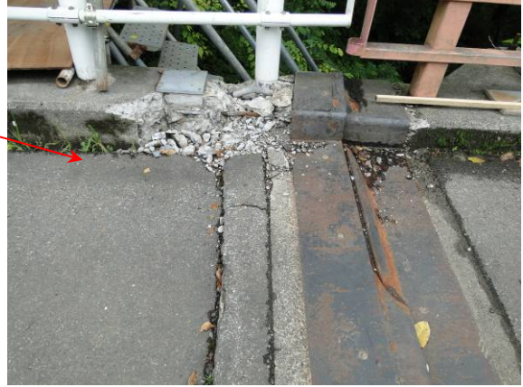
写真-4.2.16 A1 橋台伸縮装置部の損傷（上流側）
