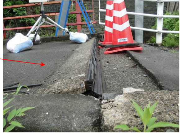
写真-4.3.8 P1 橋脚の伸縮装置の損傷
