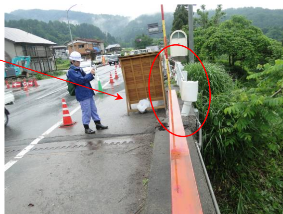
写真-4.4.4 ウイングの損傷に伴うガードレールの傾き
