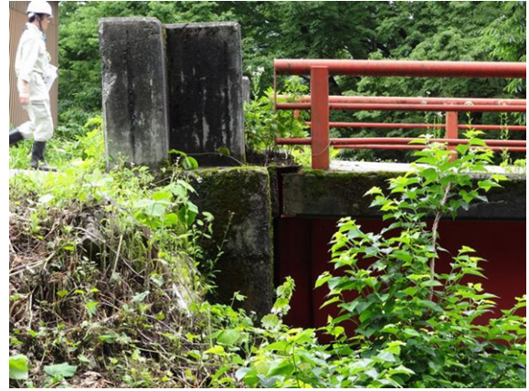
写真-4.1.8 A1 橋台パラペットの傾斜
