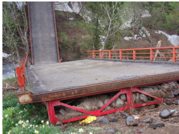
写真-4.1.41 P2 橋脚～A2 橋台間の側径間の状況（写真提供：栄村）
