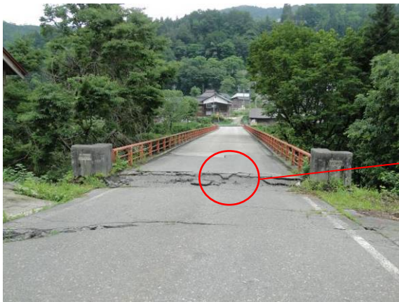
写真-4.1.3 A1 橋台背面盛土の沈下
