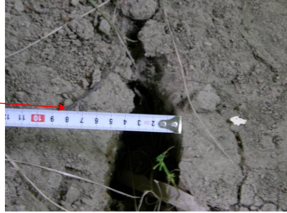
写真-4.3.20 P1 橋脚柱間付近で橋軸方向に伸びる地盤の割れ（拡大）：幅 4cm 程度
