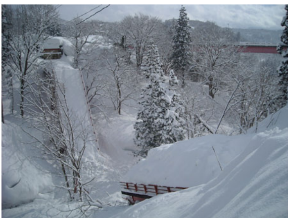
写真-4.1.28 落橋状況 (写真提供：栄村)
