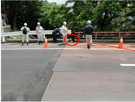
写真-4.2.3 A2 橋台ジョイント部（下流側）の状況
