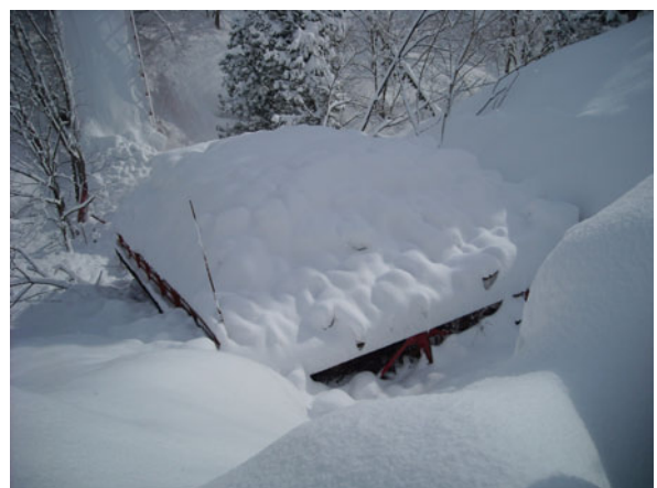
写真-4. 1. 35 P2 橋脚～A2 橋台間の側径間の桁の落橋状況(橋台側から) (写真提供：栄村)
