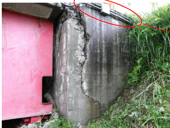
写真-4.4.3 A2 橋台パラペットとウイングの損傷
