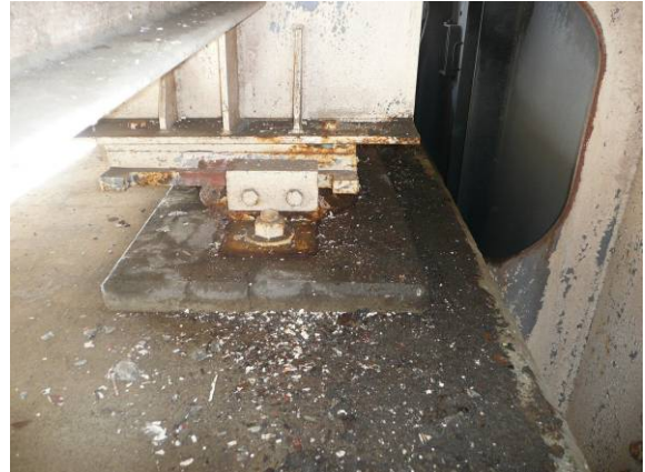
写真-4.2.30 P1 橋脚の鈹桁 (G2) の支承 の状況 (写真提供：長野 県)
