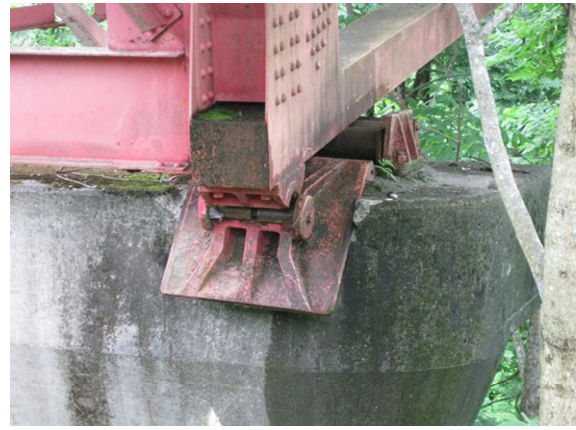
写真-4.1.26 P2 橋脚下流側可動支承の脱落
