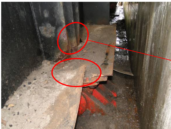
写真-4.2.11 桁端部と A2 橋台 G2 支承の状況：下フランジが一部破断
