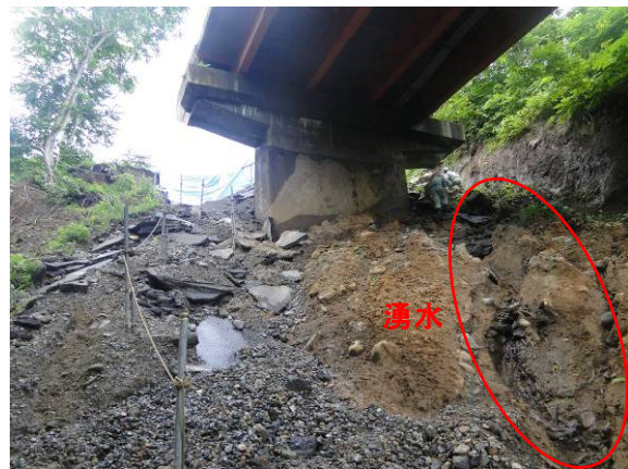
写真-4.5.4 P1側から見たA1橋台の状況
