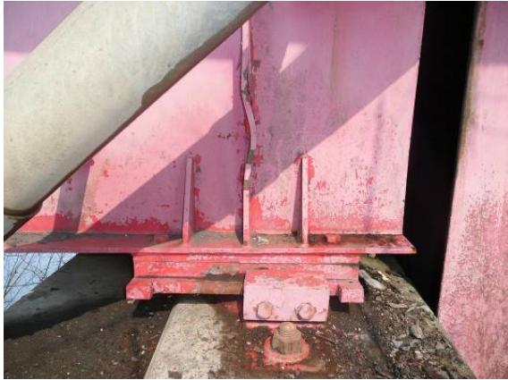
写真-4.2.29 P1 橋脚の鈹桁 (G5) 端部の 損傷状況：補剛材の座屈 (写真提供：長野県)
