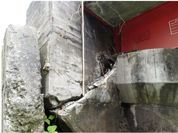
写真-4.1.15 A2 橋台パラペットの損傷
