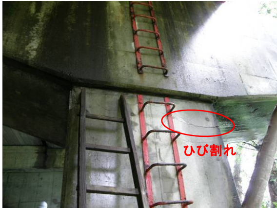
写真-4.3.13 P1 橋脚谷側柱上端部の損傷 (拡大) : 谷側の側面で水 平ひび割れが発生
