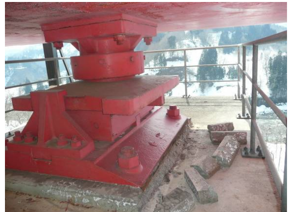
写真-4.2.32 P2 橋脚 G1 支承部の損傷状 況：沓座モルタルの割れ (写真提供：長野県)
