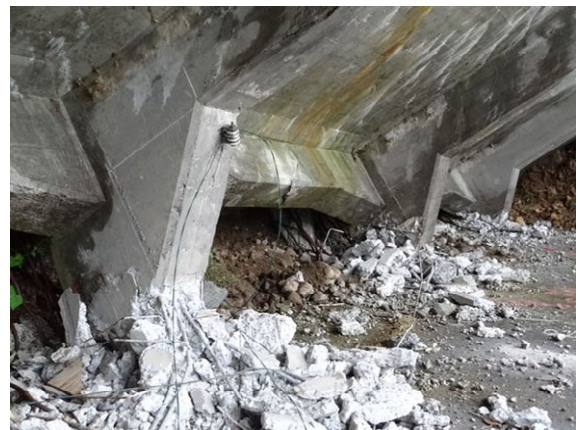
写真-4.6.8 山側柱の破壊状況（原形を留めず）
