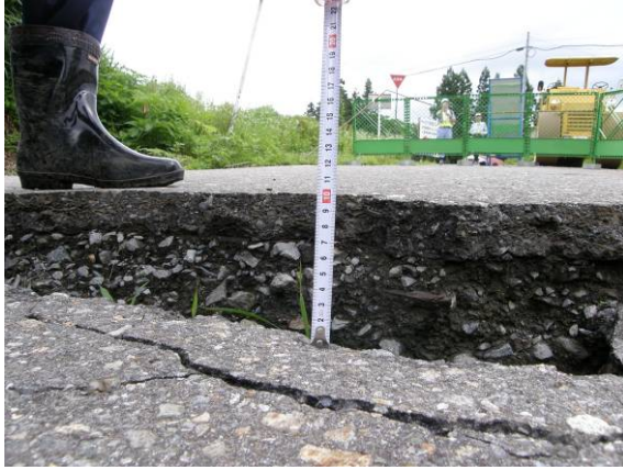
写真-4.1.7 A1 橋台背面盛土の沈下による路面の段差（約 10cm）
