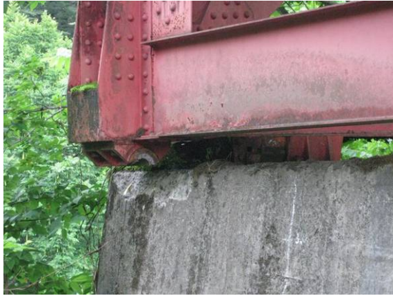
写真-4.1.25 P2 橋脚上流側可動支承の脱落
