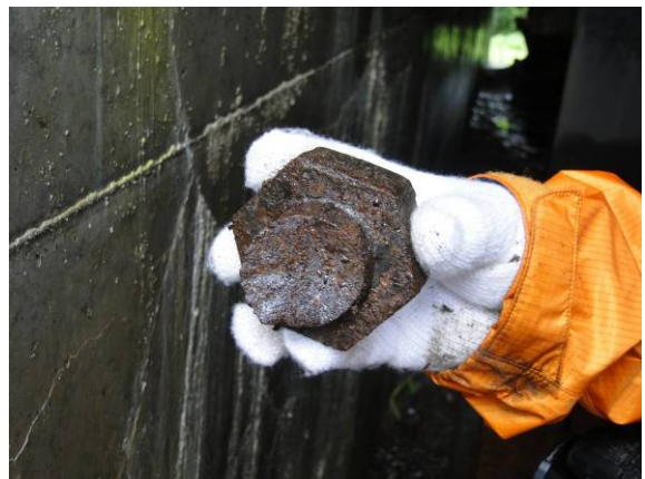
写真-4.2.14 A2 橋台 G1 支承上沓セットボルトの破断面
