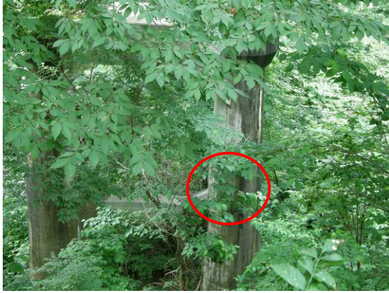
写真-4.1.19 P1 橋脚柱部のコンクリートの損傷
