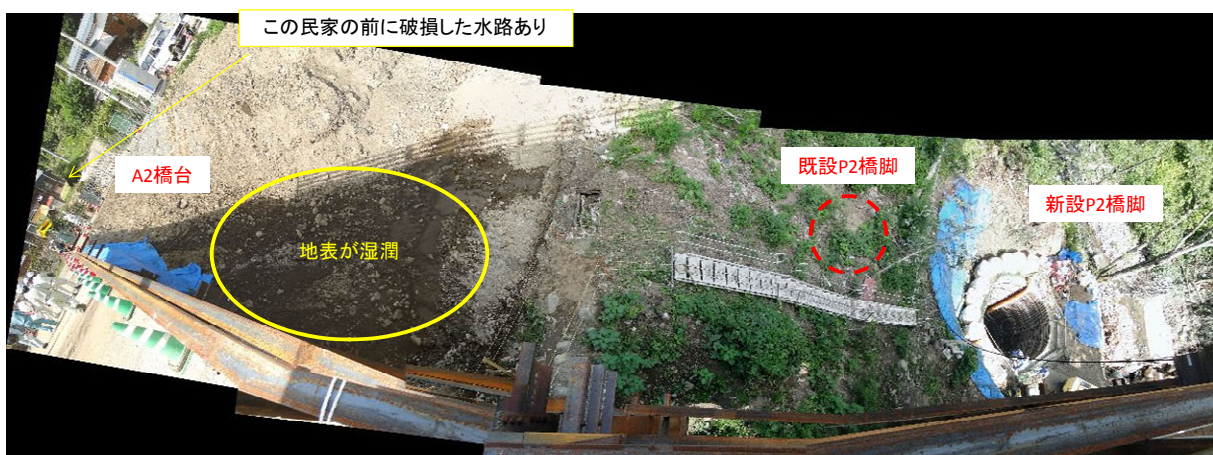
写真-4.1.27 A2～新設 P2 橋脚周辺の状況 (工事用の仮橋の上から撮影した複数の写真を合成したもの)
