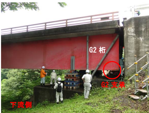
写真-4.2.7 A2 橋台桁端部の状況
