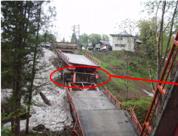
写真-4. 1. 42 P2 橋脚と側径間の落橋状況 (写真提供：栄村)
