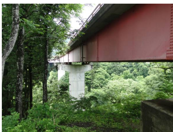
写真-4.2.1 橋梁全景 (A2 側より撮影)
