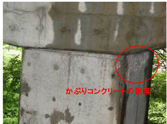
写真-4.3.12 P1 橋脚谷側柱上端部の損傷 (拡大) : 山側の側面がかぶりコンクリートが剥落
