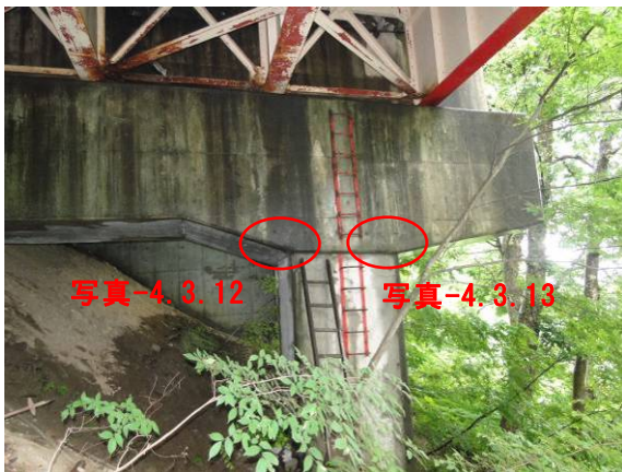
写真-4.3.11 P1 橋脚谷側柱上端部の損傷
