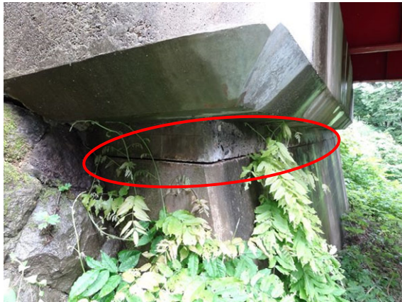
写真-4.1.9 A1 橋台の打ち継ぎ部の隙間（約 11mm）
