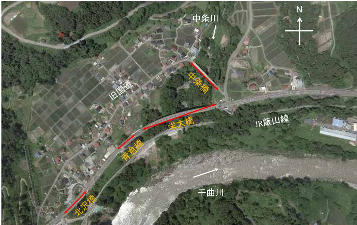
図-3.3 中条橋，栄大橋，青倉橋および北沢橋周辺の航空写真（2011年7月6日撮影 2) ）
