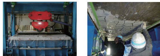
写真-1 輪荷重走行試験 写真-2 床版への剥離剤塗布
