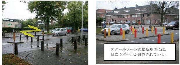
写真1 交通島で直角に曲がる横断歩道(右: 通学路の横断歩道)
