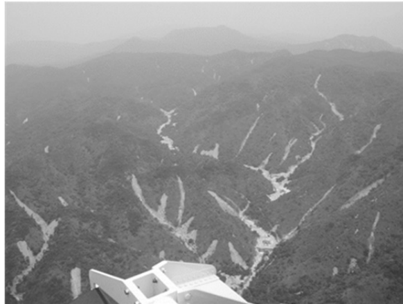
写真1 表層崩壊の多発（2009年山口県防府市）
