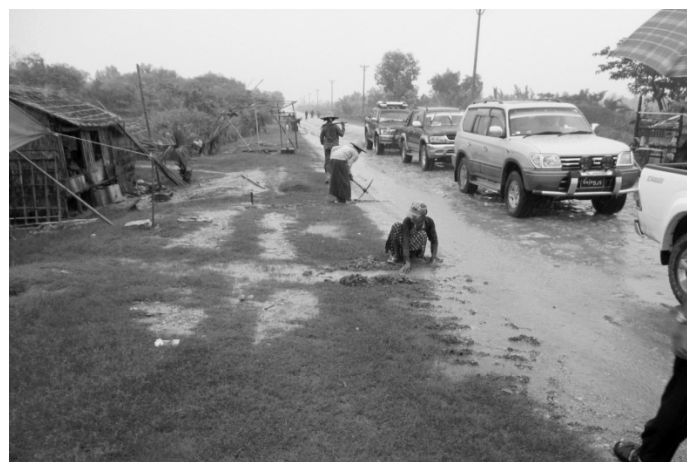
写真1 ミャンマーの道路状況 降雨時、道路に水が溜まるため、政府の委託を受けた近隣の農民が道路脇に溝を掘り、水を流し出す様子。
