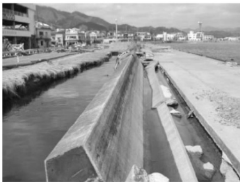
(a) 堤体が陸側に倒壊した事例 (大船渡港海岸茶屋前地区)
