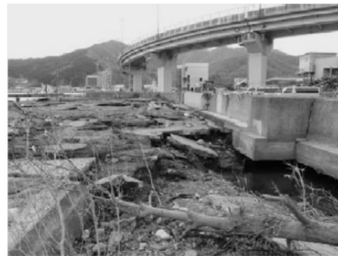
(b) 海側が洗掘された事例 (釜石港海岸須賀地区)
