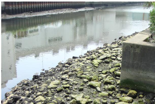
写真-2 干出した礫混じりの浅場 (砂町北運河)
