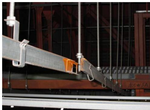
写真 2.2 野縁受けジョイントの外れ
