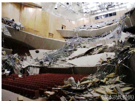
写真 1.3 大規模ホールの被害
