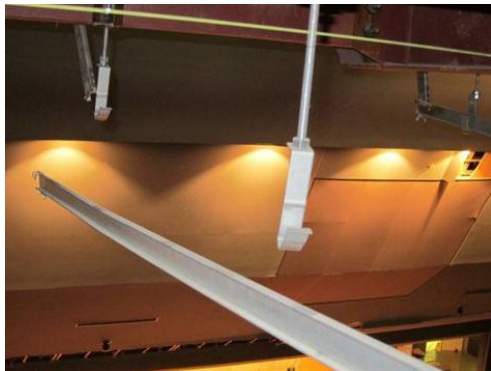
写真 2.3 ハンガーの開きによる外れ
