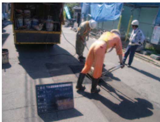
陥没地点画像
