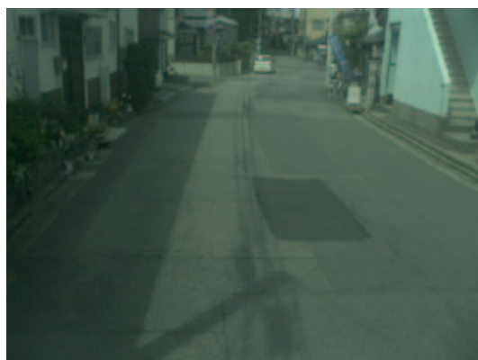
第二回計測時 MMS カメラ画像
