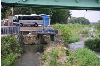
箕浦橋から下流区間は堤防(道路:ガードレール部)の標高が低く、事実上の越流堤になっている
