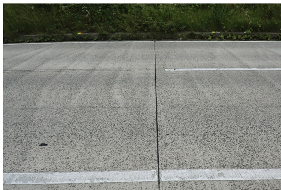
写真 2.1 健全な目地材の例
