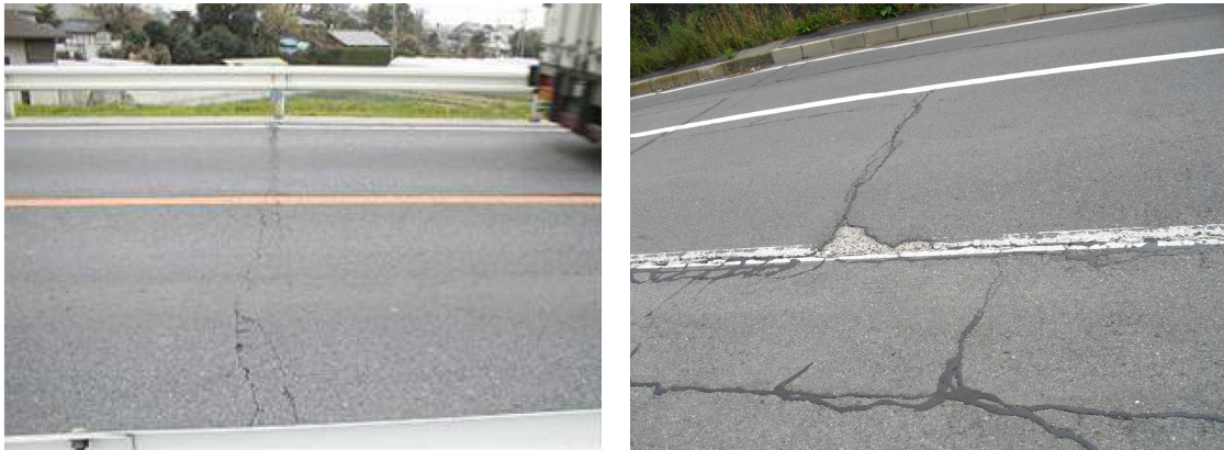
写真 2.19 リフレクションクラックの例
