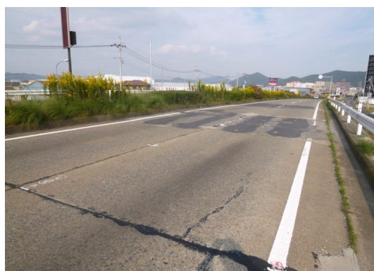
②縦ひび割れ
