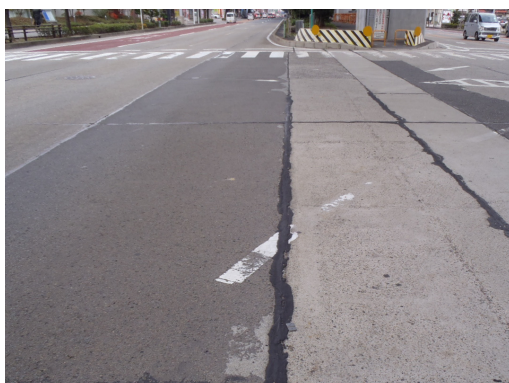
写真 2.2 目地材のはみ出しの例 1)
