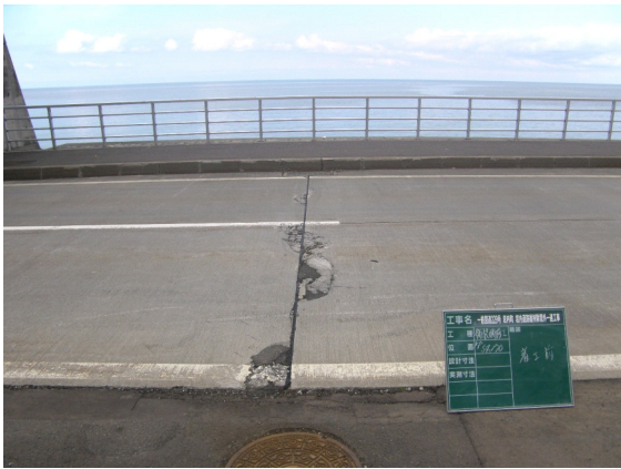
(収縮目地部の角欠け)
