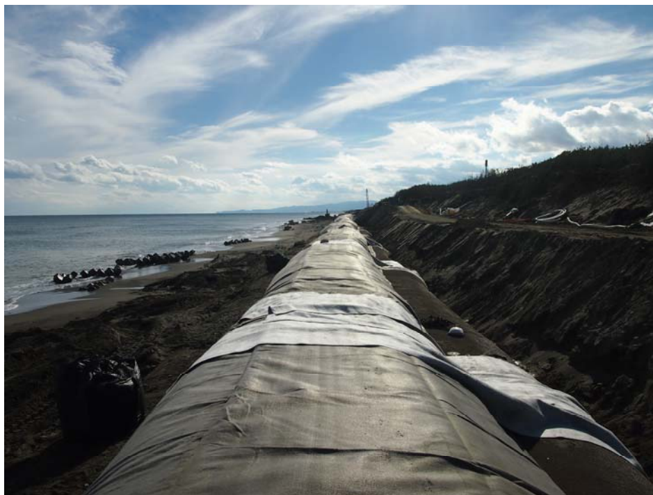
写真Ⅱ-1.1.1 宮崎海岸埋設護岸設置状況
