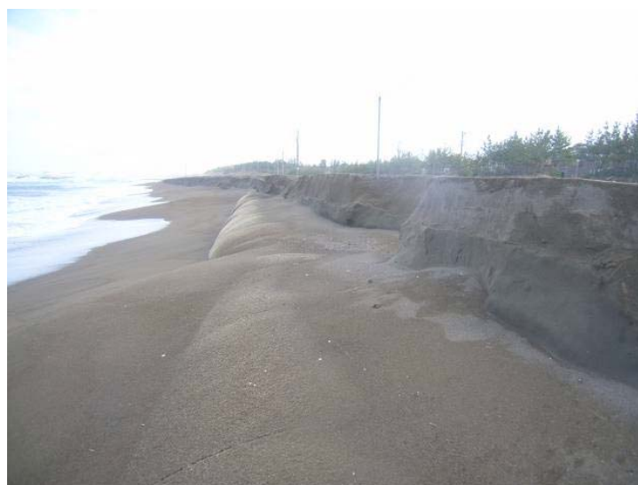
写真 I-1.1.1 砂浜になじんだ浜崖後退抑止工
