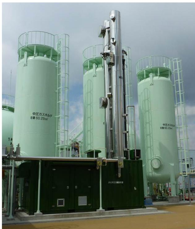
写真2-8 新型バイオガス精製・貯留・圧送システム
