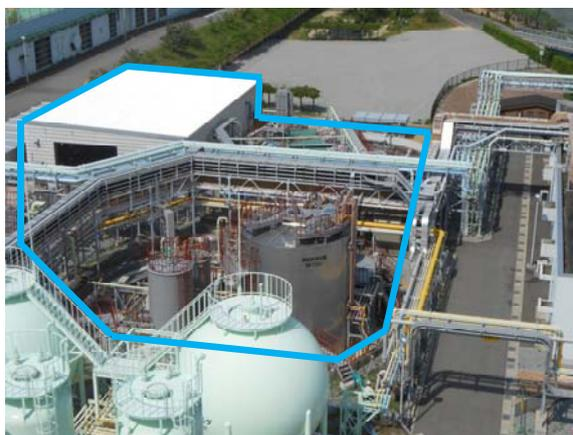
写真 2-1 バイオガス回収技術関連設備
