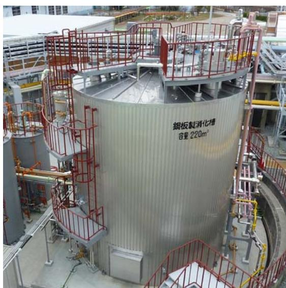
写真2-5 鋼板製消化槽 (有効容量 220 m<sup>3</sup>)
