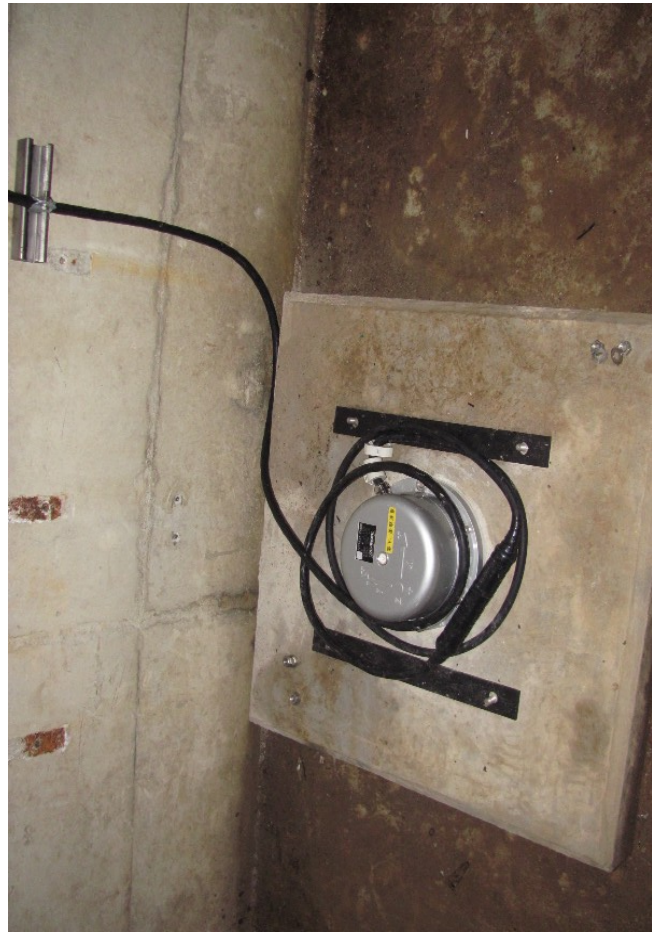
L1 (底設監査路感震器)
