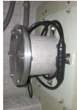
T1 ダム天端水位計室内
