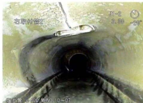
写-1 破損の事例
