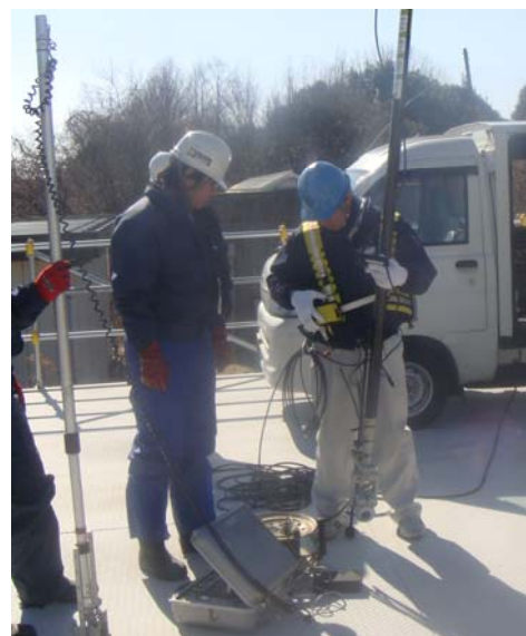
写真-4.1 管口カメラ
