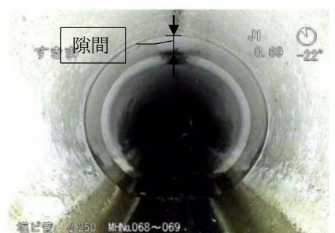
写-4 隙間の事例
