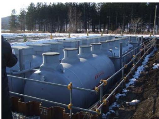
写真-1 接触酸化型 (北海道安平町)
