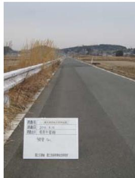
写真-5 液状化対策施工（被害なし）
