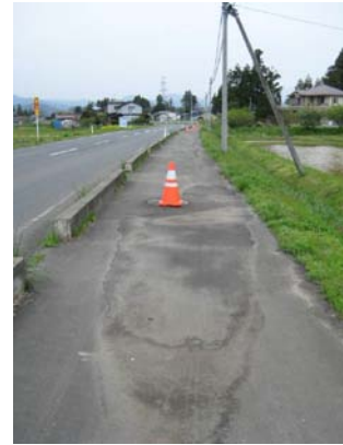
写真－3 液状化対策施工箇所（被害軽微）
