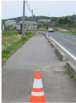
写真－2 液状化対策施工箇所
