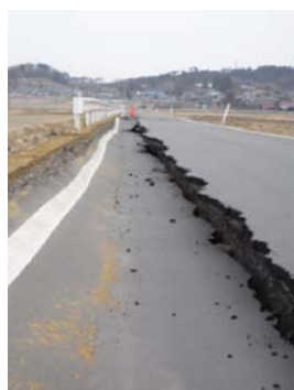
写真－4 標準施工
