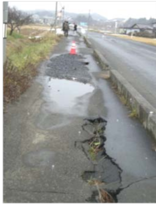
写真－1 標準施工（未対策）
