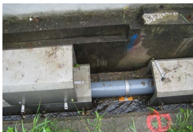
写真-4 側溝活用型クイック配管（二戸市）
