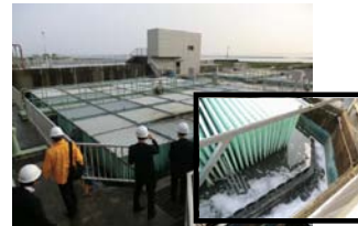
接触酸化法を用いた簡易生物処理
