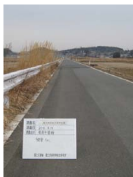
写真－5 液状化対策施工（被害なし）
