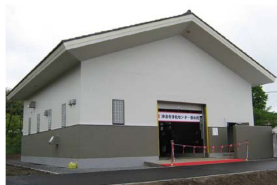
写真－3 PMBR外観（二戸市）
