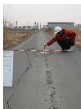
写真－6 液状化対策施工（被害有り）
