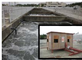
簡易曝気装置を用いた生物処理
