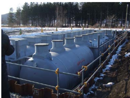
写真－1 接触酸化型（北海道安平町）
