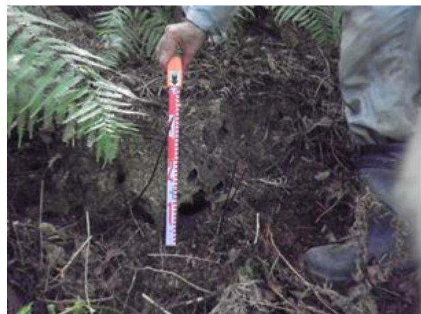
写真-5.2.24 滑落崖背後斜面の段差状況
