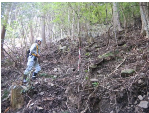
写真-5.2.36 全体ブロックに向かって右側方の段差や亀裂および緩み
