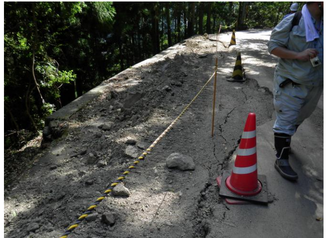
写真-5.1.4 路肩の沈下（地すべりの押し出し）
