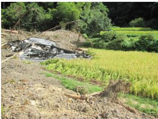
写真-5.2.23 堆砂域での側方への盛りこぼれ状況。手前側は土砂が比較的高含水状態で広がったと推定され、奥側は砂礫の安息角で堆積したと推定される。
