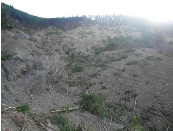
写真-5.2.10 崩落斜面の近景
