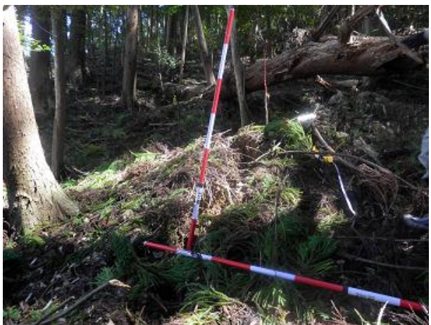
写真-5.2.6 滑落崖背後で確認されたクラック
