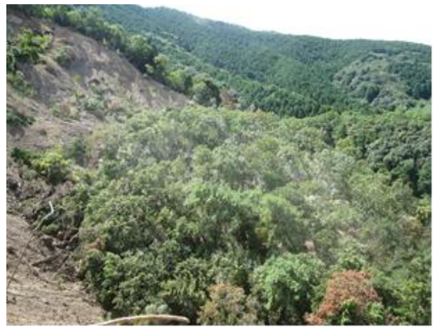
写真-5.2.20 不安定土塊を側方から望む。樹木は比較的整然と林立しているが、山側に向かって傾いている。
