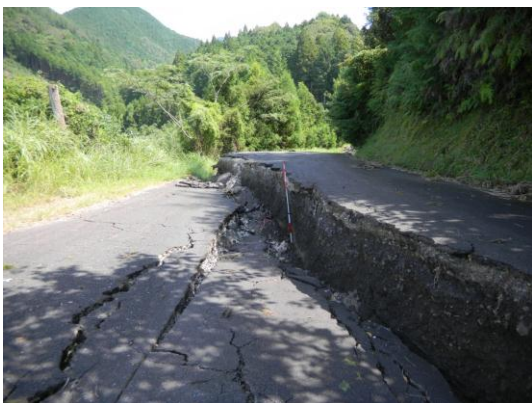
写真-5.2.31 市道を横断する亀裂および段差
