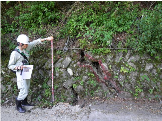
写真-5.1.3 石積の亀裂（地すべり側部）
