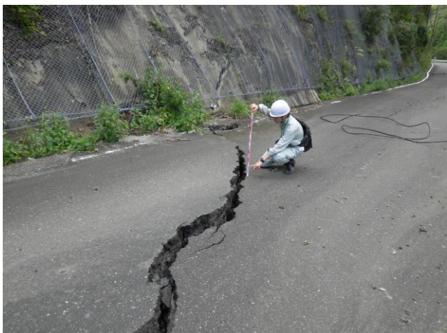
写真-5.1.7 旧道の段差亀裂
