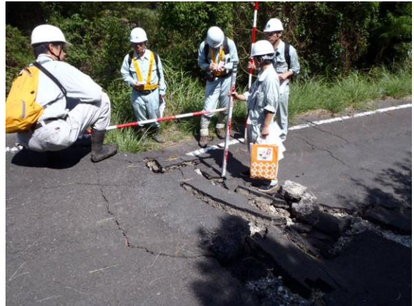
写真-5.2.28 頭部の市道を横断する約1m段差（ブロックは支川に向かい移動）
