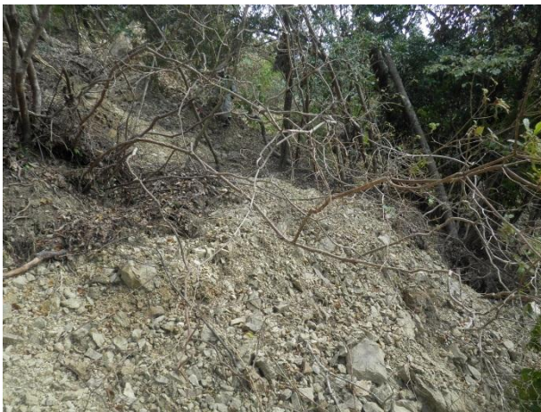
写真-5.2.21 不安定土塊末端部の状況。土塊が砂礫状にバラバラに崩れている。
