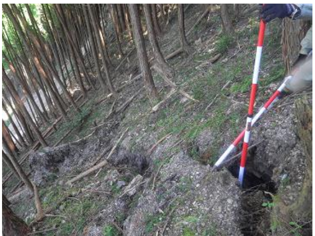
写真-5.2.7 斜面上部の落ち残り部で確認されたクラック
