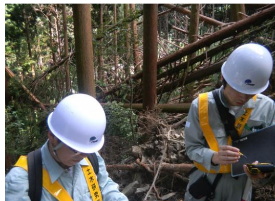
写真-5.2.37 末端の崩落部の上部
