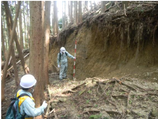
写真-5.2.34 頭部の滑落崖（高さ2～4m）
