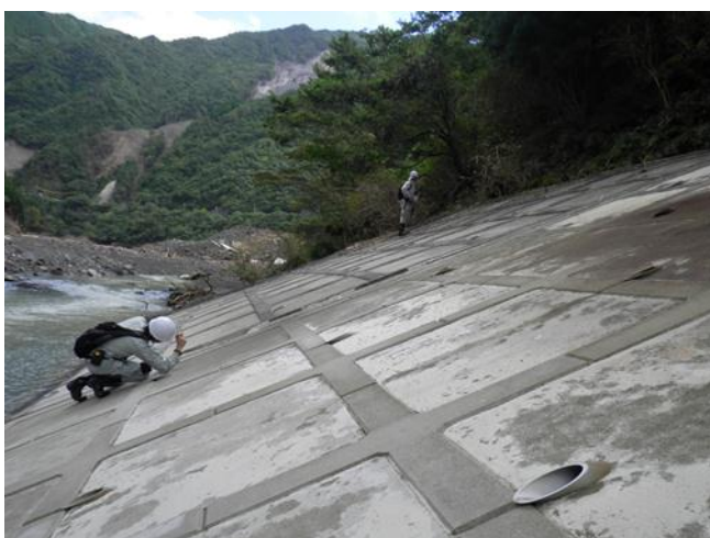
写真-5.1.9 護岸のはらみだし
