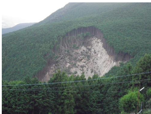
写真-5.2.26 真砂地区（崩壊斜面の頭部）
