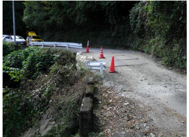
写真-5.1.2 県道の段差（地すべり側部）
