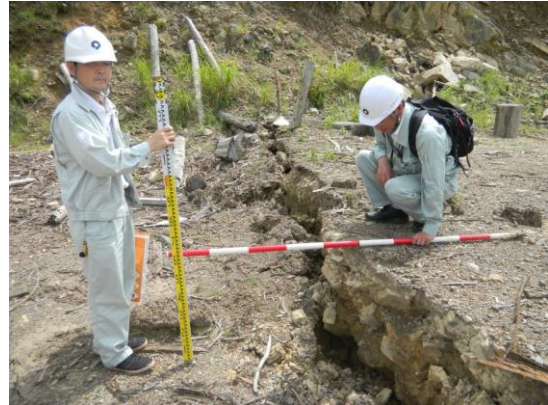
写真-5.2.30 作業道を横断する亀裂および段差
