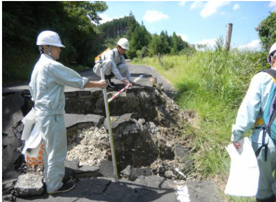
写真-5.2.29 頭部の市道を横断する約1mの段差
