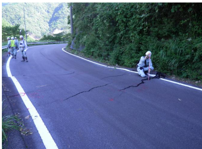
写真-5.1.6 旧道の段差亀裂
