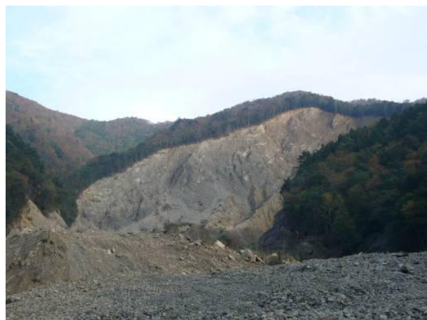
写真-4.4.1 東又谷で発生した崩壊
