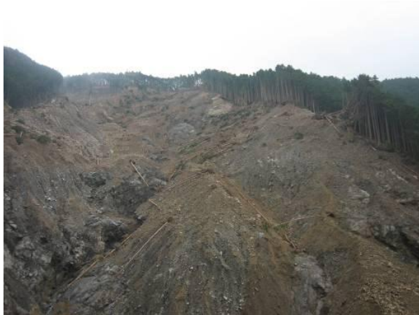
写真-4.4.2 持山谷川で発生した崩壊
