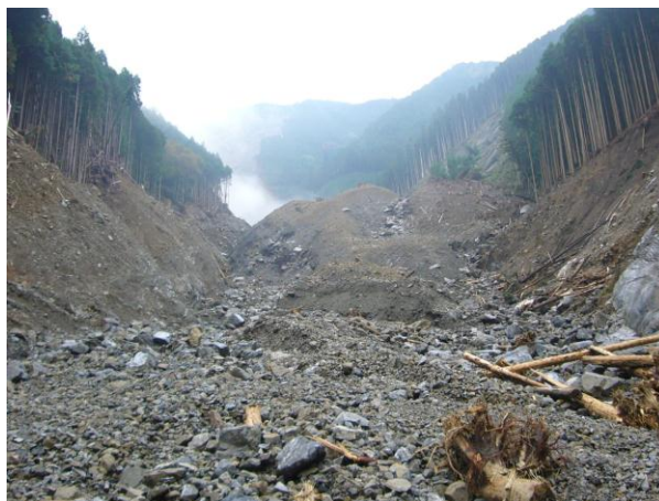
写真-4.4.3 持山谷川河道で確認された大量の不安定堆積土塊（河道から上流を望む）
