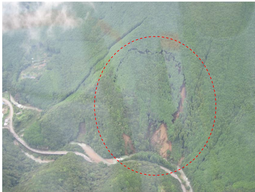
写真-4.1.16 亀裂の状況
