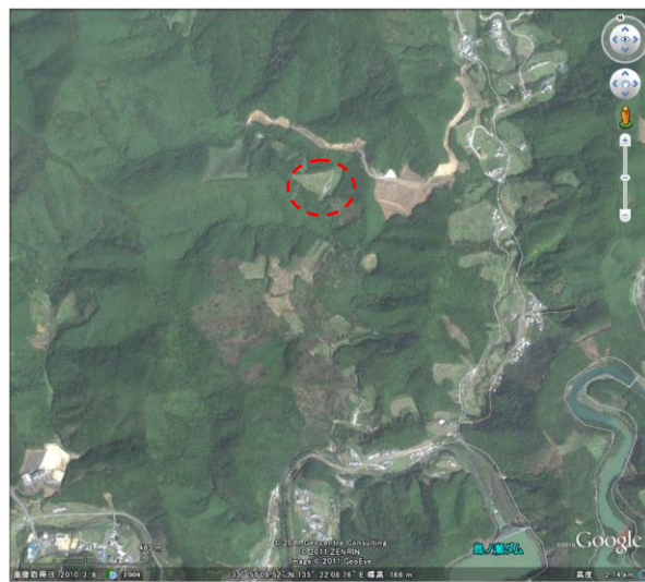
写真-4.1.11 島之瀬地区河道閉塞位置
