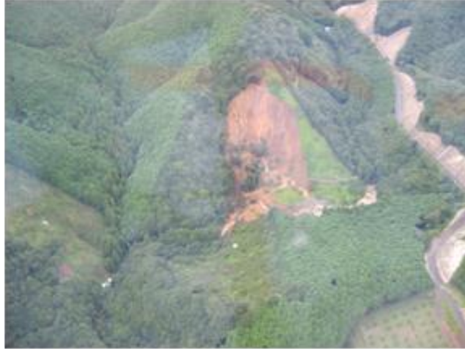
写真-4.1.9 島之瀬地区河道閉塞
