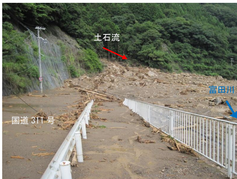
写真-4.1.14 流出土砂の堆積状況
