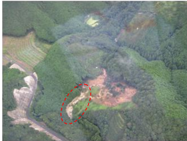
写真-4.1.10 島之瀬地区河道閉塞の湛水状況
