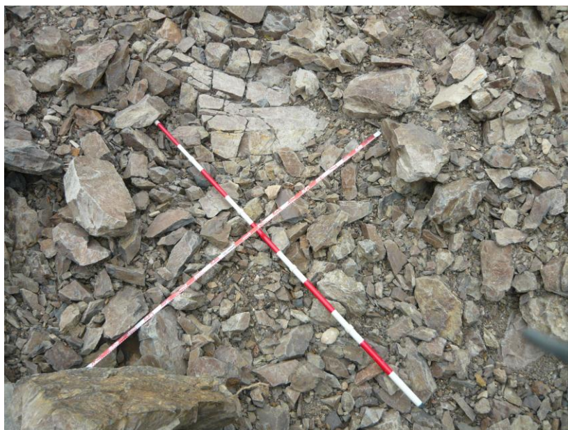
写真-3.7.2 越流水路の河床の状況（2011年10月2日撮影）
