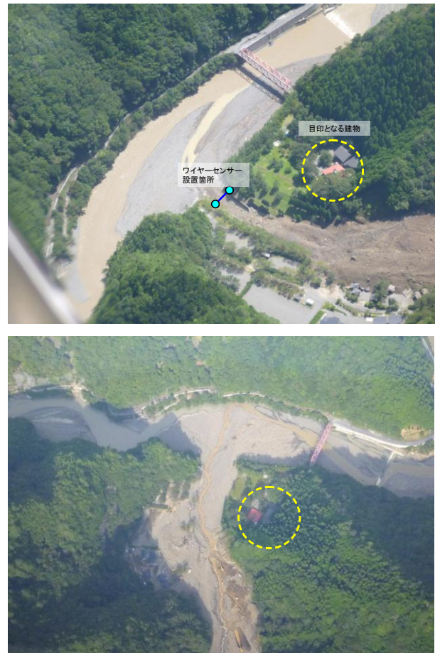
図-3.6.2 赤谷のワイヤーセンサーの設置箇所の状況
