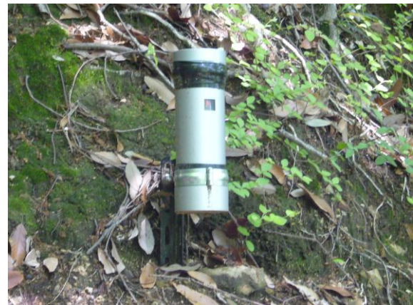
写真-3.6.1 斜面崩壊検知センサー
