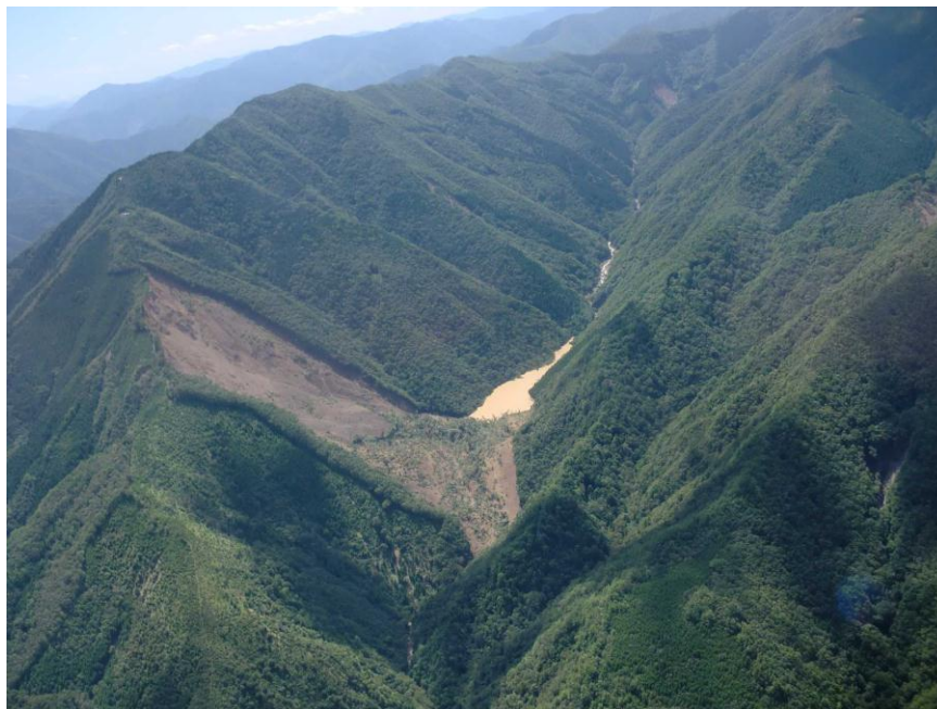
写真-3.2.5 長殿地区の状況（9月6日12時00分頃撮影）
