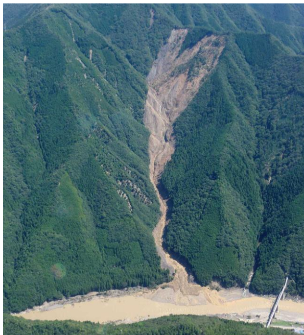
写真-3.2.7 野尻地区の状況（9月6日12時30分頃撮影）
