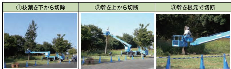
写真-5 危険木伐採の例
