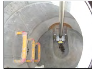
簡易カメラによる可視範囲確認実験 (マンホール内)
