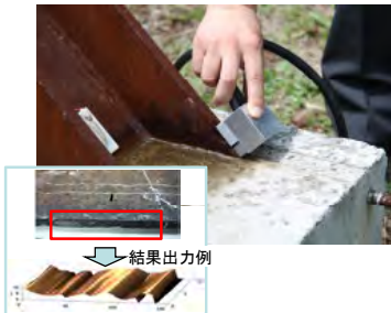
鋼材内部(腐食形状)を可視化 (超音波フェーズドアレイ)
