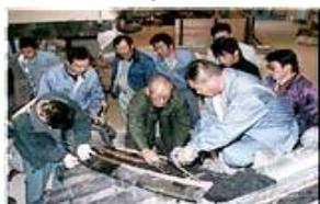
図 3-76 瓦科(本瓦葺の作業)
