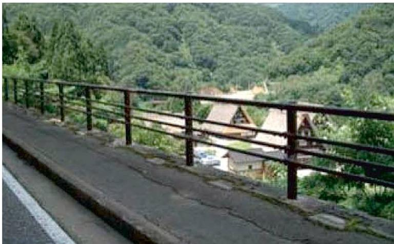
図 3-92 色彩をダークブラウン、構造を横棧式とした転落防止柵(富山県南砺市菅沼集落)
