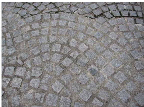
図 3-86 小舗石舗装の施工事例
