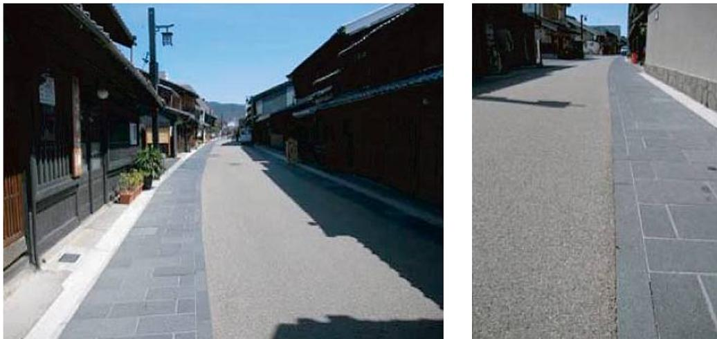
図 3-88 舗装方法の違いにより車道と歩行空間を明示した例(岐阜県川原町)
