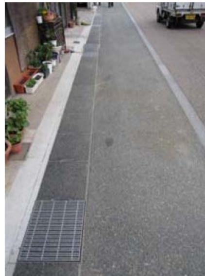
図 3-93 道路舗装と側溝上蓋の表層を合わせた例(愛知県犬山市)
