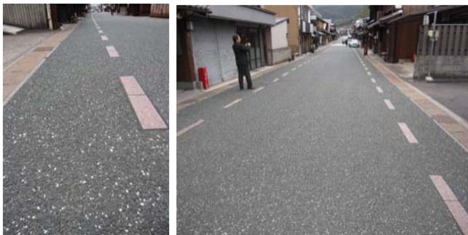
図 3-84 自然石アスファルト舗装の例(岐阜県美濃市)
