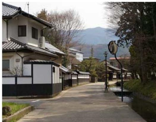
図 3-83 脱色アスファルト自然色舗装の例
