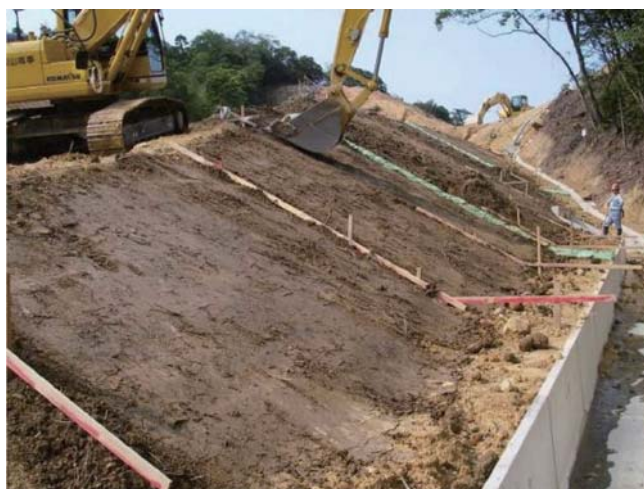
写真-3.7 土羽土工の施工状況
