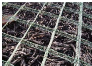
写真-4.5 表面に立体構造ネットを張った植生基材吹付工
