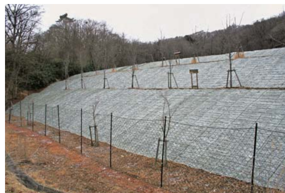
写真-6.5 シカの侵入防止柵の例
