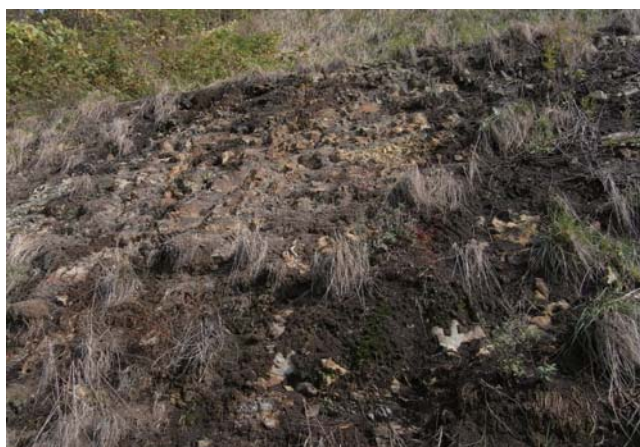
写真-6.6 生育基盤の崩落
