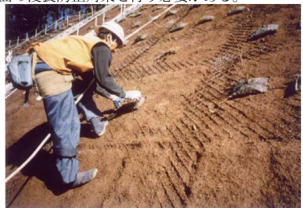
写真-5.6 ユニット苗工の施工状況
