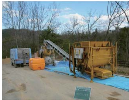
写真-3.8 植生基材吹付工の施工状況
