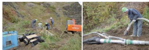
【表土の採取状況】
