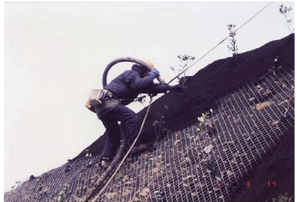
写真-5.5 苗木設置吹付工の施工状況
