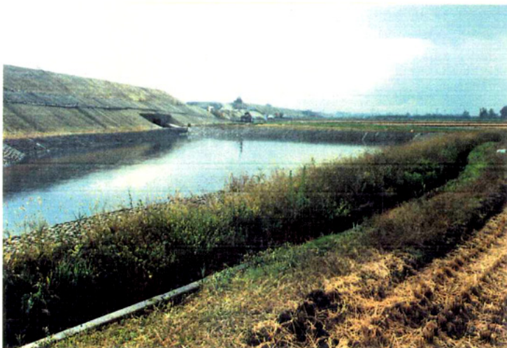
ブロックマット工 施工後 全 景 (平成5年10月)
